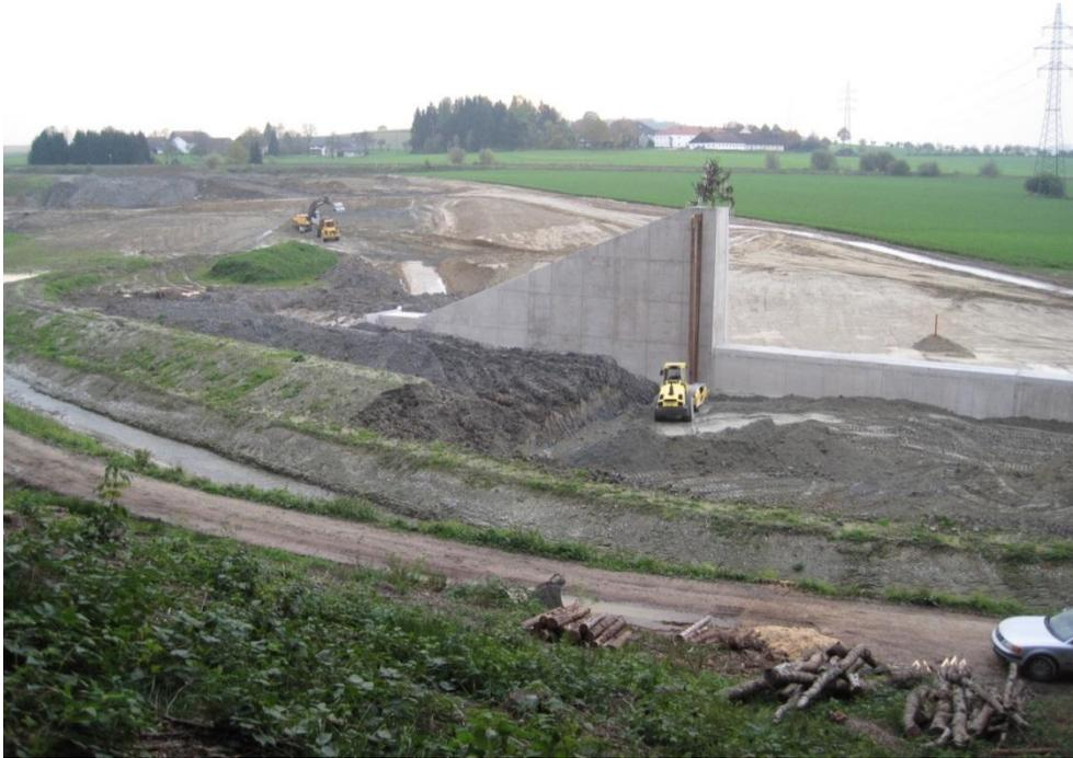
Fertiges Durchlassbauwerk und Dammbauarbeiten am rechten Ufer (c) GWB Braunau
