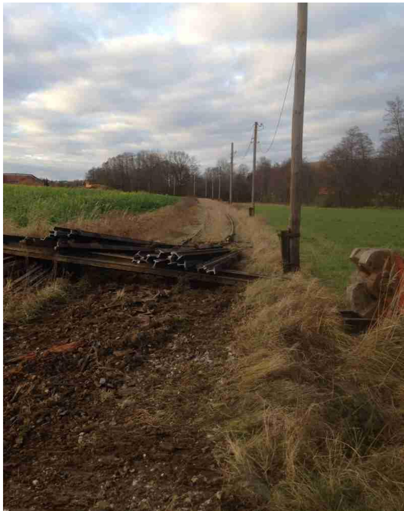
Abbildung 2: Gleisentfernung im Jahr 2017
