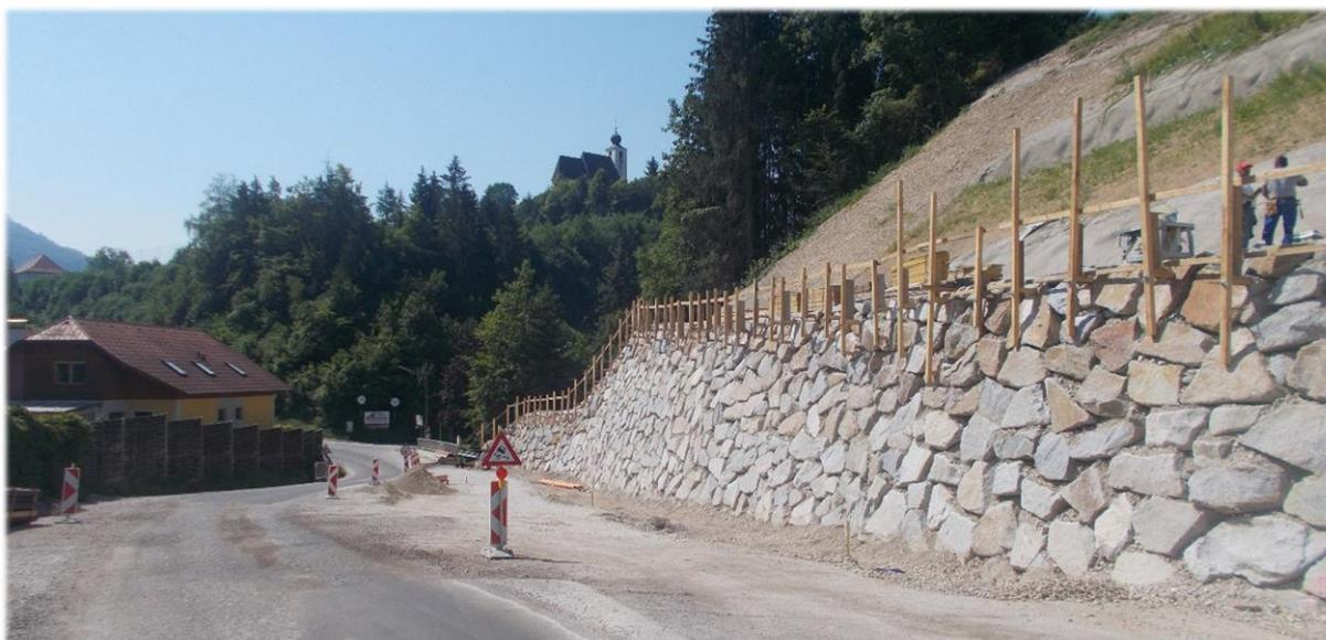
Abbildung 8: Steinschichtung am "Bäckerberg" Quelle: Direktion Straßenbau und Verkehr – Land OÖ
