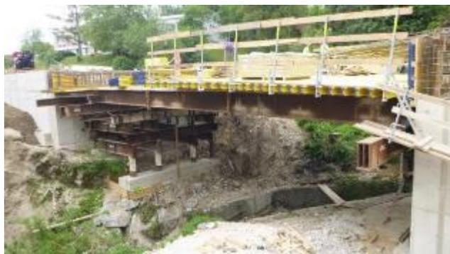
Tragwerk vor dem Betonieren
