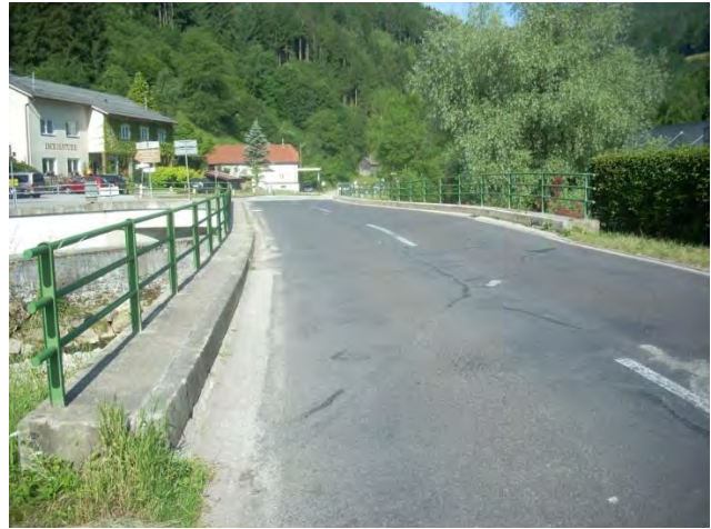
Hausmannbrücke Richtung Steyr
