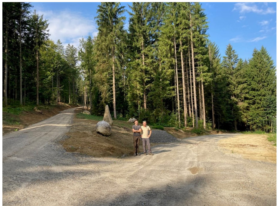
Forststraße Lamprechtswiesen in Oberkappel, Fertigstellung September 2023, Projektierung und Bauaufsicht durch den Forsttechnischen Dienst der BH Rohrbach. (links: Forstadjunkt Stefan Schachl-Lughofer, rechts: Bezirksförster Ing. Sebastian Köppl) Foto: Land OÖ
