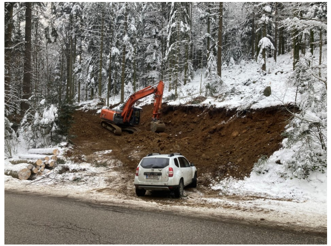
Baubeginn der Forststraße Edtei in Putzleinsdorf im Jänner 2023, Fertigstellung September 2023 Foto: BH Rohrbach
