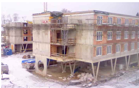
Rohbau des Bezirksaltenheimes Rohrbach
