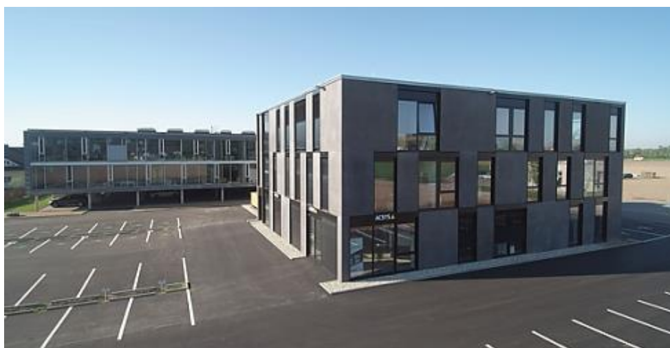
Technologiezentrum Perg (Quelle: Technologiezentrum Perg GmbH)
