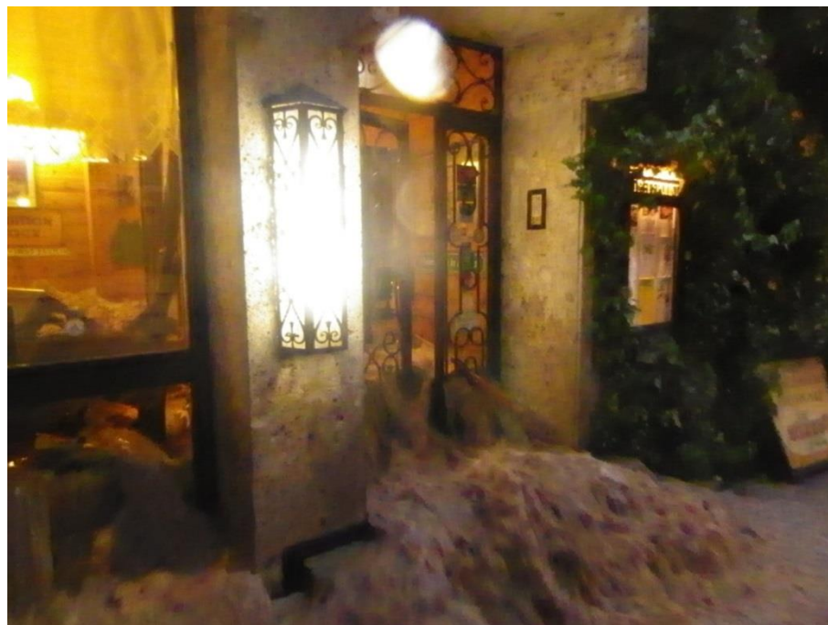
Abbildung 160: Überflutungen und Überschotterungen des Keller- und Erdgeschosses beim Gasthof Seewirt
