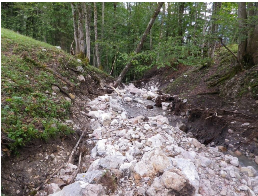
Abbildung 170: Erosionsstrecke im Langmoosbach
