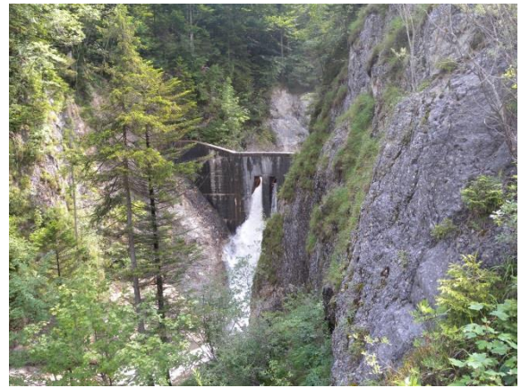
Abbildung 135: ~hm 2, Sperre unbeschädigt
