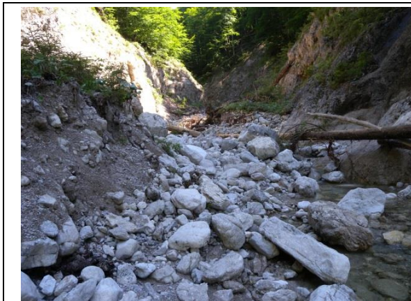
Abbildung 52: hm 81,5: seitlicher Anbruch durch Unterschneidung
