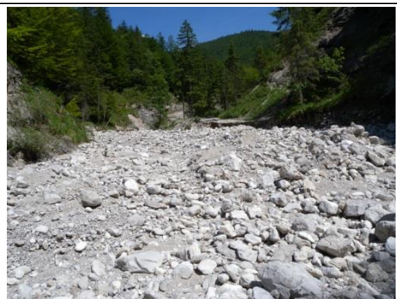
Abbildung 55: große Geschiebeumlagerungen, Eintrag aus lu. Graben, hm 79
