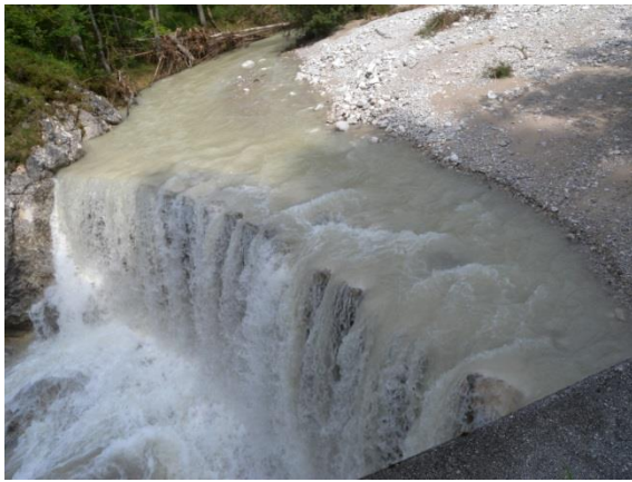
Abbildung 134: ~hm 6,7, Sperre unbeschädigt
