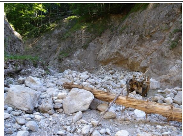
Abbildung 53: Erosion im Gerinne (hm 82)
