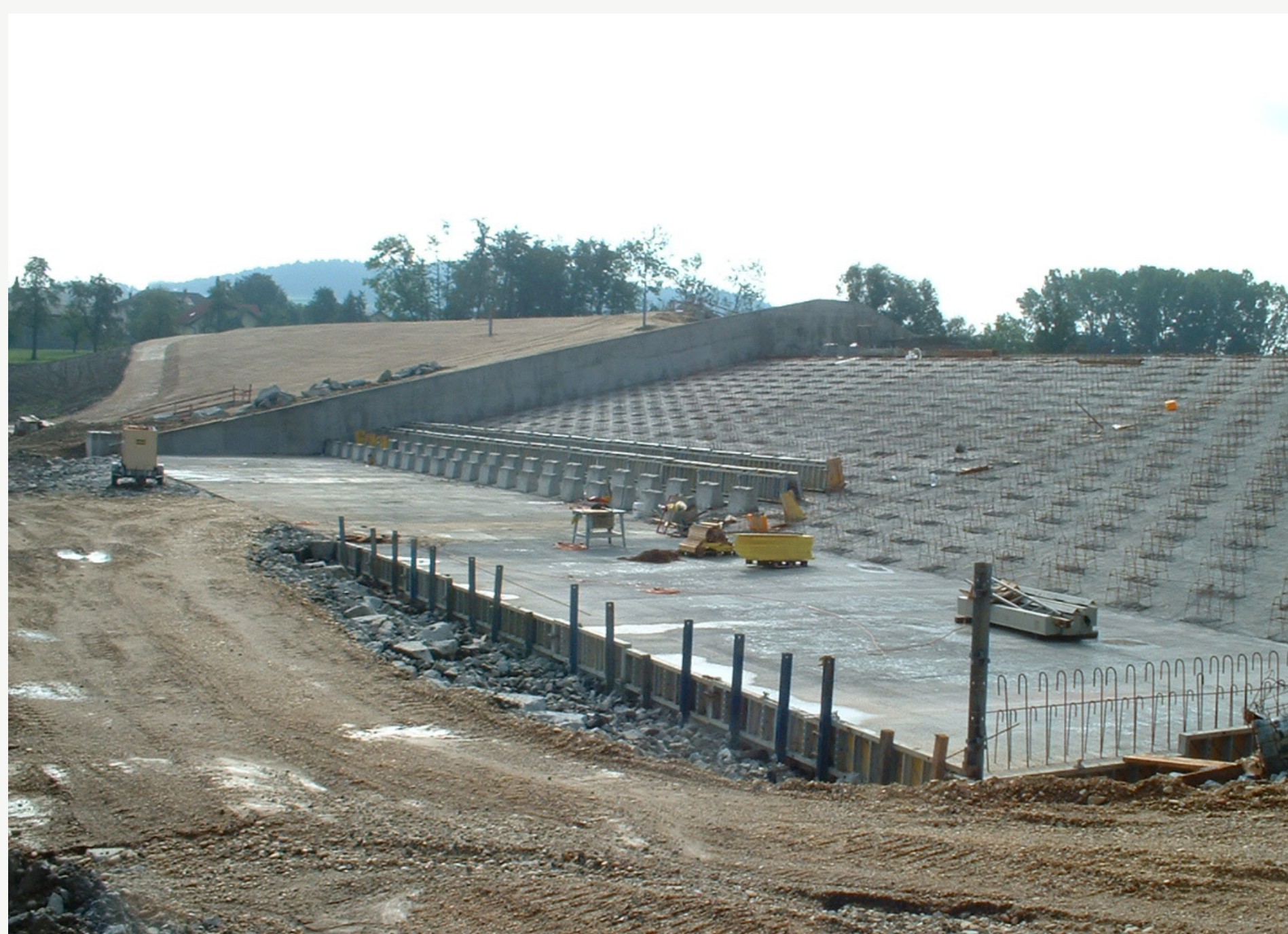
Betonarbeiten an der Überlaufsektion
