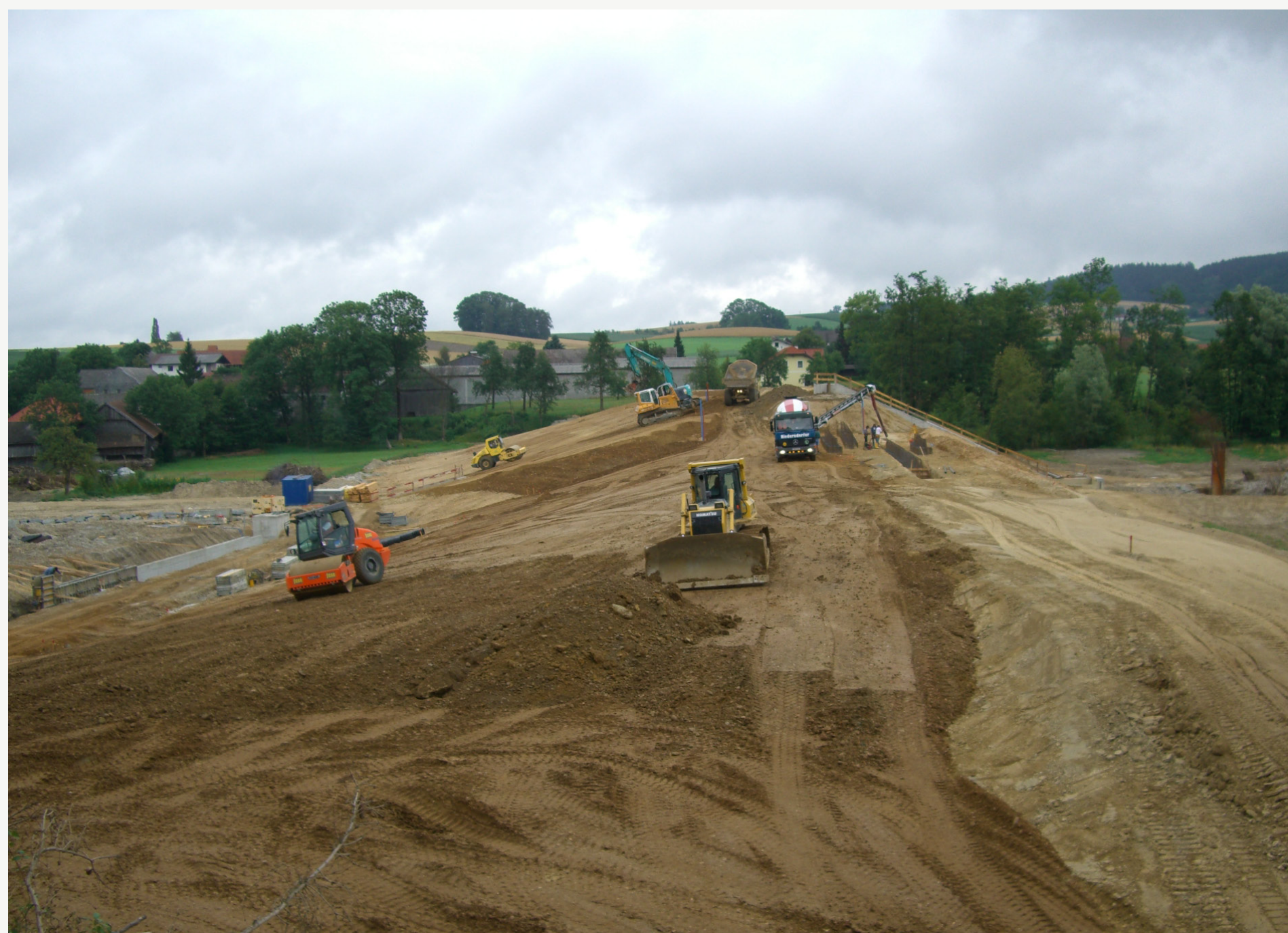
Baugeräte bei der Dammerichtung
