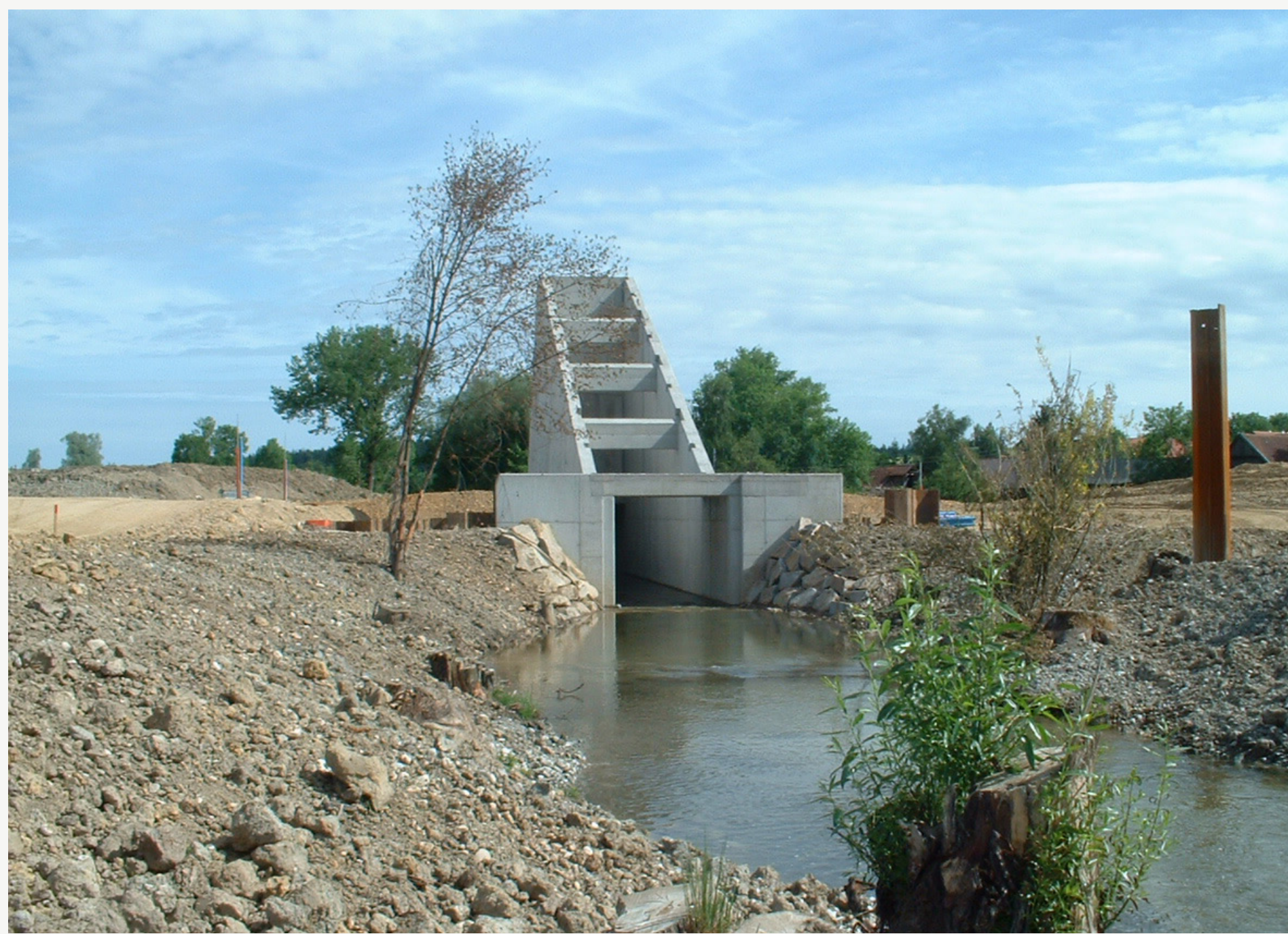
Durchlassbauwerk ohne Damm
