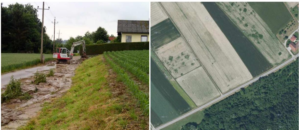
Abb. 28 *Links: Komplette verfüllter Graben nach Starkregenereignis (Punkt 21, 10.06.2015).*
