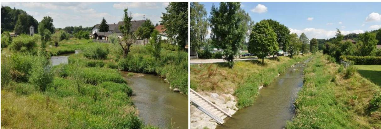
Abb. 116 Links: Renaturierung der Pram im Bereich Riedau; Durch großzügigere Platzverhältnisse und angepasste Strukturierung bilden sich trotz Feinsedimentbelastung wertvolle Choriotope aus.
