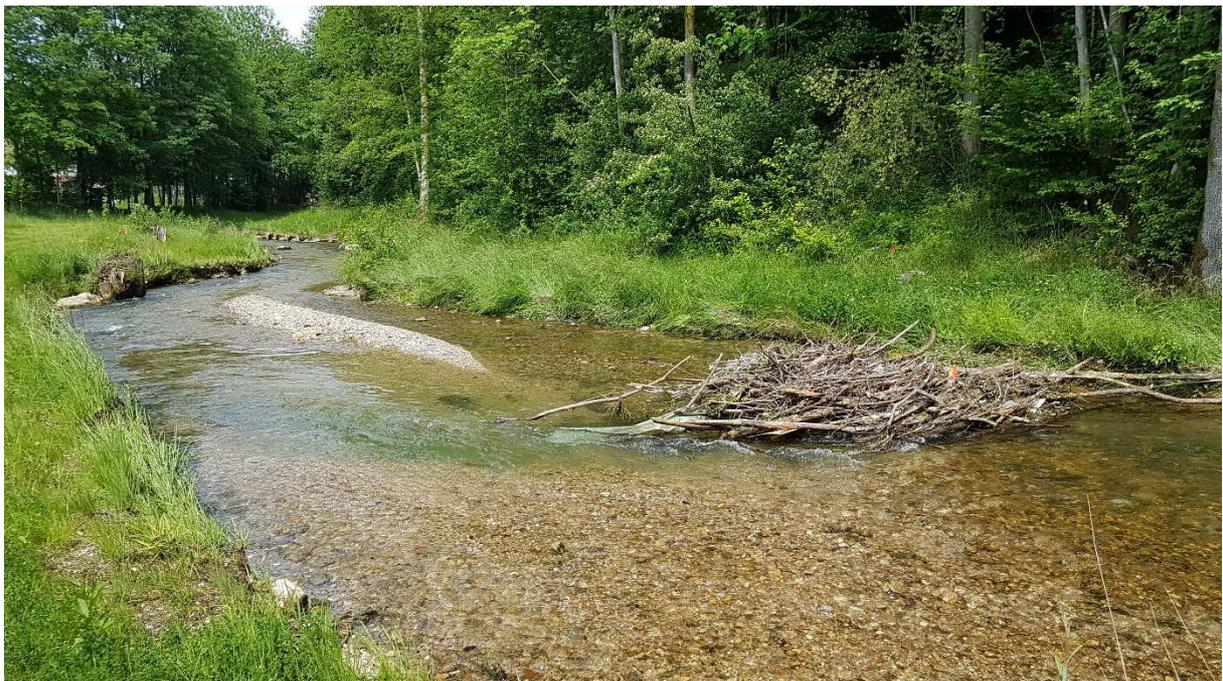
Abb. 137 An einem eingebauten Wurzelstock bei der Maßnahme Astmühle hat sich Schwemmholz gesammelt und führte zu einer ökologisch sehr wertvollen Habitatvielfalt (2018).
