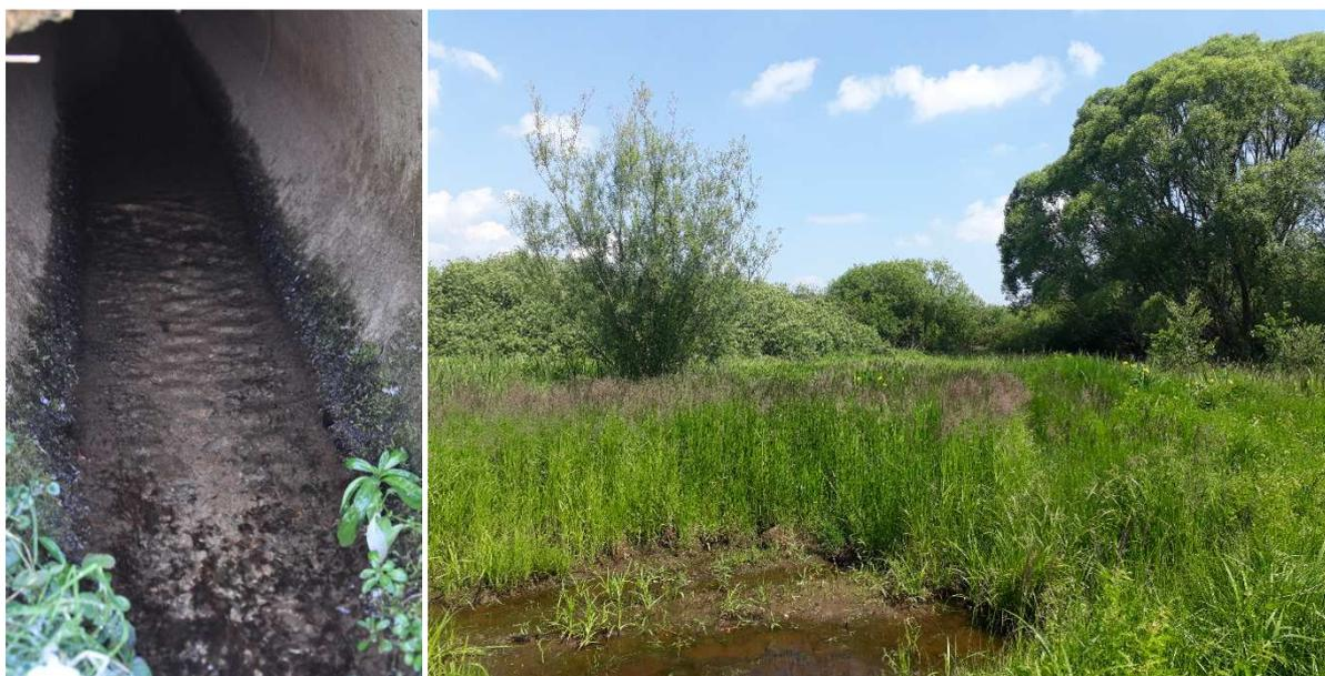
Abb. 141 Großdrainagen Einleitungen an der Maltsh: links... konventionell direkt in das Gewässer; rechts... über eine Feuchtwiese im Uferbereich, wo Feinsedimente und Nährstoffe zurückgehalten werden.
