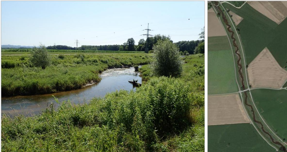
Abb. 5 *Links: Aufwertungsabschnitt flussauf der Mündung. Rechts: Der Fluss wurde nach Entfernung der Ufersicherung innerhalb des bestehenden Kastenprofils in einen pendelnden Lauf gelegt.*
