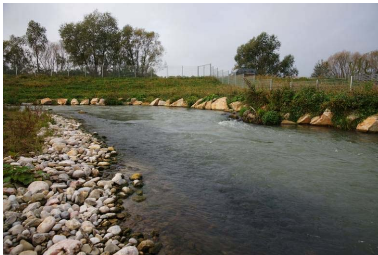
Abbildung 40: Flachufer eines asymmetrischen Raugerinnes am Beispiel des Verbindungsbauwerks Flutmulde Machland / Au a. d. Donau
