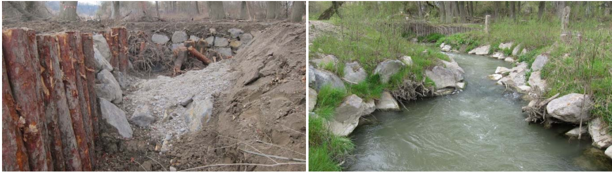
Abbildung 49: Beispiel für asymmetrische Ausformung eines Beckenübergangs (Verbindungsgerinne Altarm Lateiner – Pielachmündung); links: im Bauzustand; rechts: im Betrieb
