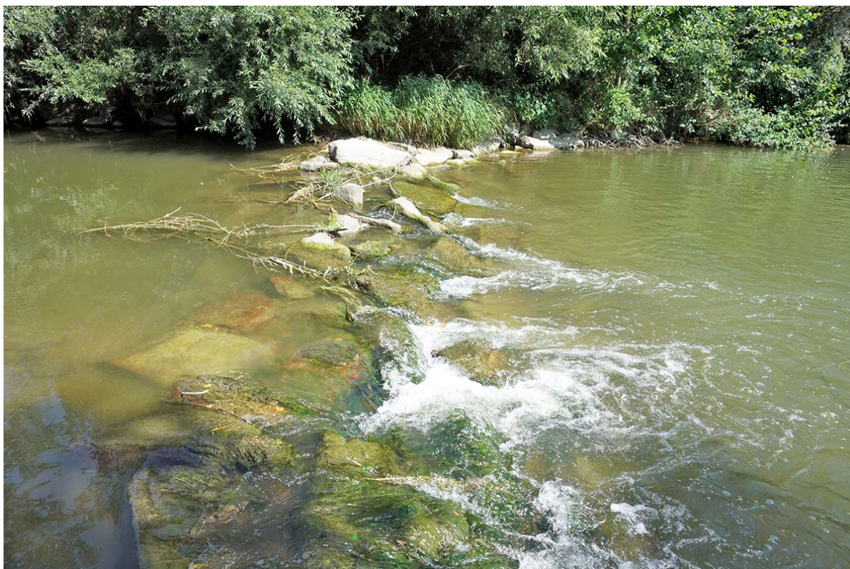
Abbildung 5: Mittlere Sohlrampe bei Fluss-km 8,17.
