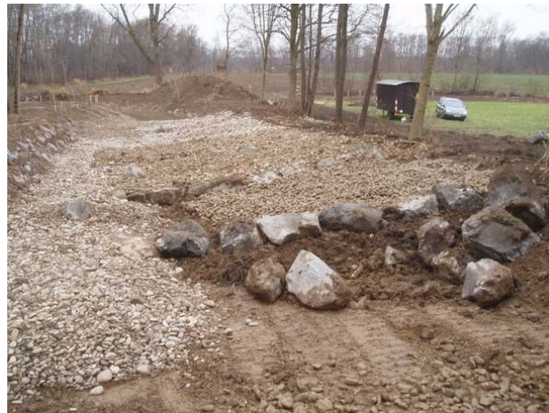
Abbildung 41: Aufbau der asymmetrischen Gerinnesohle aus Querriegeln und grobem Kies (Gerinne ohne Hochwasserbelastung). Beispiel Ruppühle bei Halbenrain an der Mur (ZAUNER & MÜHLBAUER, 2007)
