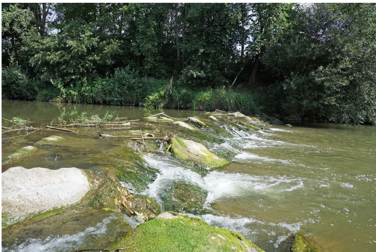
Abbildung 6: Oberste Sohlrampe bei Fluss-km 8,42.
