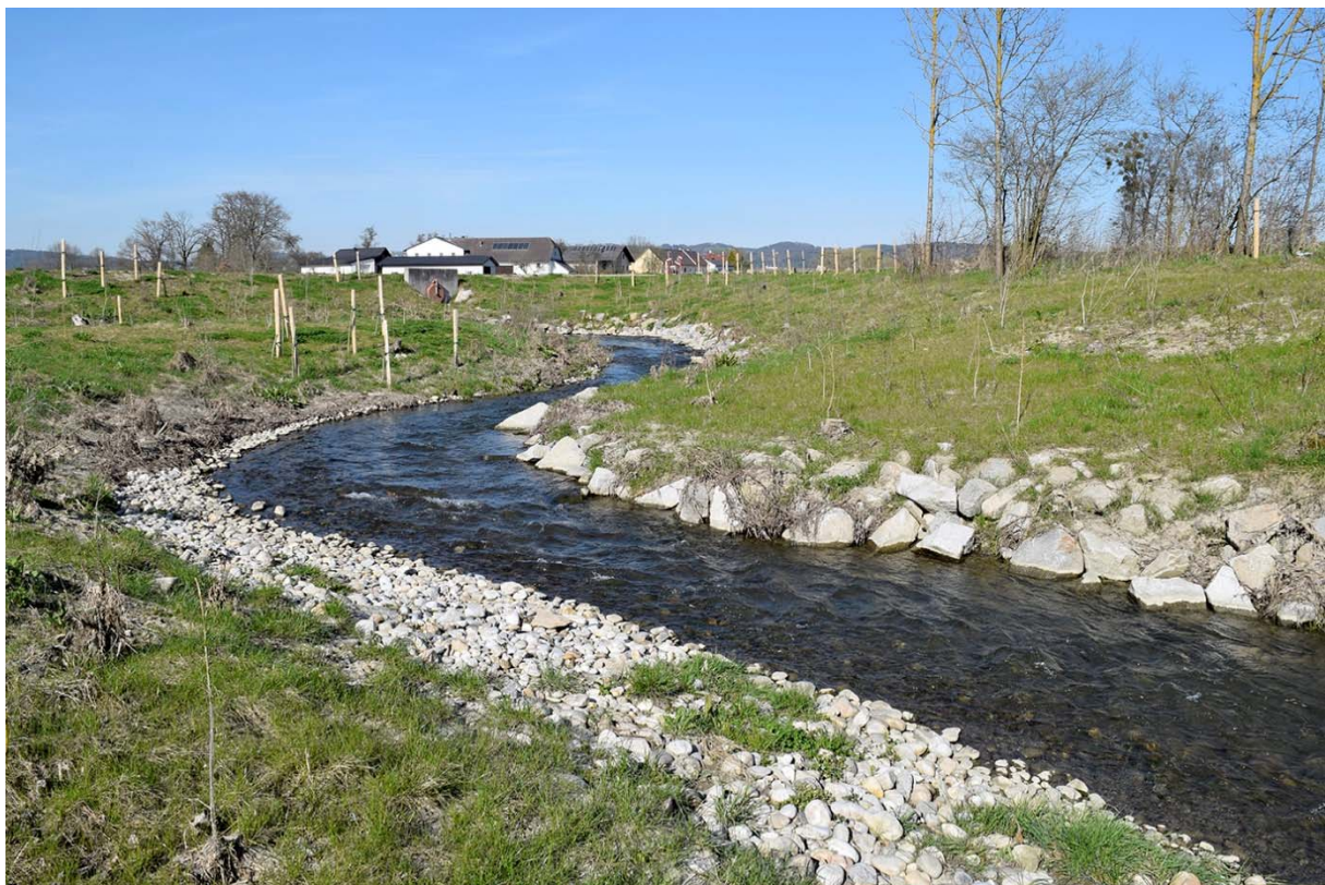
Abbildung 8: Der mittlere Teil des Asymmetrischen Raugerinnes kurz nach Baufertigstellung im Juni 2016.
