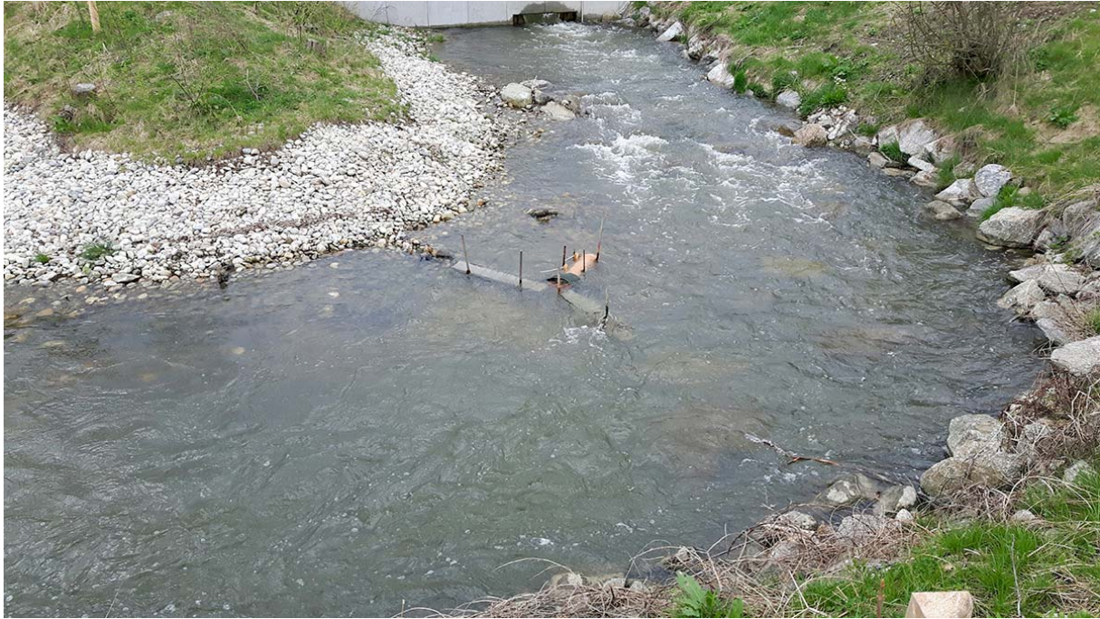
Abbildung 18: Kleinfischreuse in der FAH knapp unterhalb des Ausstiegsfensters, bestehend aus U-Profilen als Leiteinrichtung und einem durchlöchererten Polokalrohr mit 2 Kehlen als Reuse.
