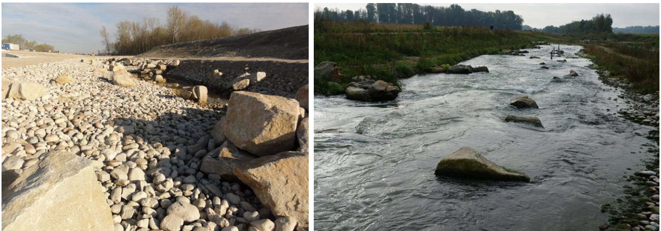
Abbildung 43: Verteilung von Rauigkeitselementen in einem asymmetrischen Raugerinne ohne Hochwasserbelastung mit und ohne Abfluss (Verbindungsbauwerk Flutmulde Machland / Donau)
