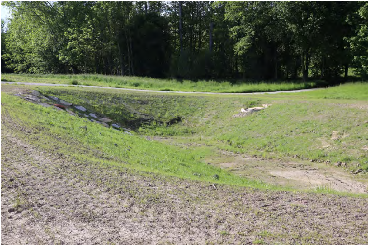
Rückhaltebecken an einem wichtigen Abflussweg bei Starkregenereignissen im Messenbach-Einzugsgebiet (© Sarah Höfler).
