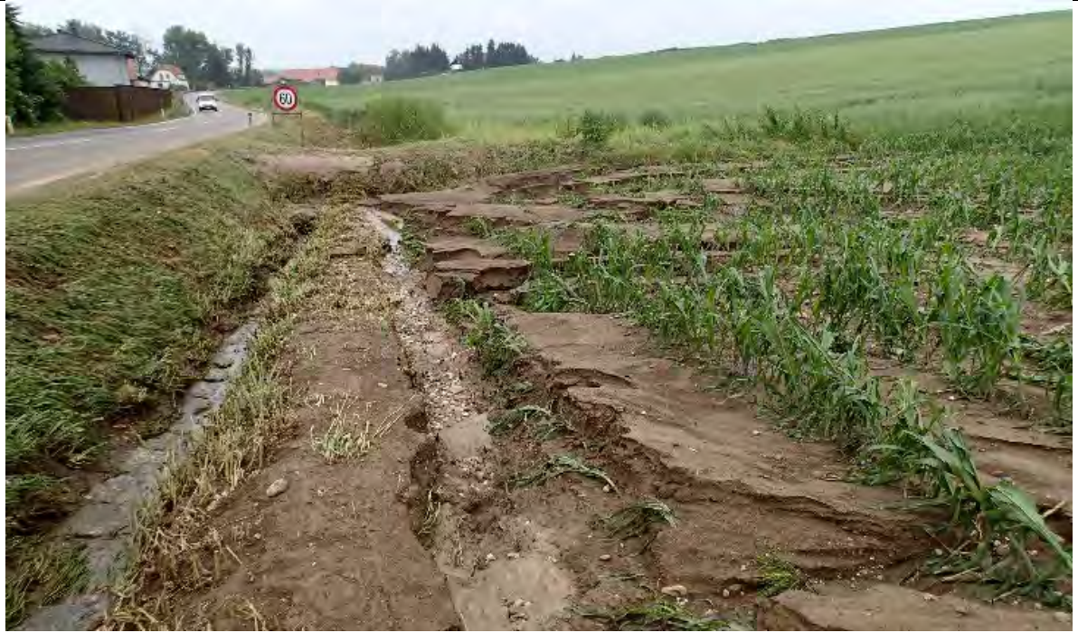
Negativbeispiel – der Maisacker endet direkt in der Straßenentwässerung (© Sarah Höfler).
