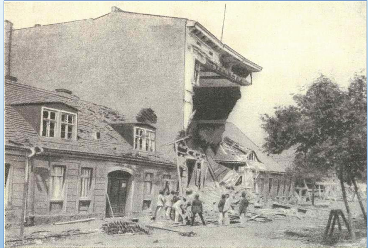
... wird rasch ein Grundbruch
