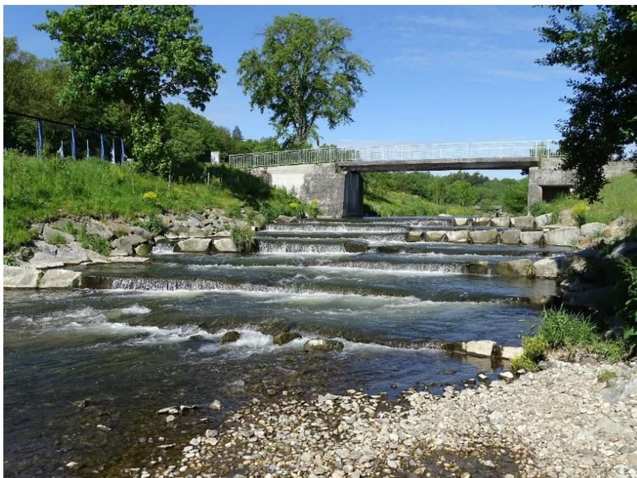
Abb. 18: In eine aufgelöste Rampe umgebaute Hammermühlstufe, 26.5.2021, Blick flussauf.
