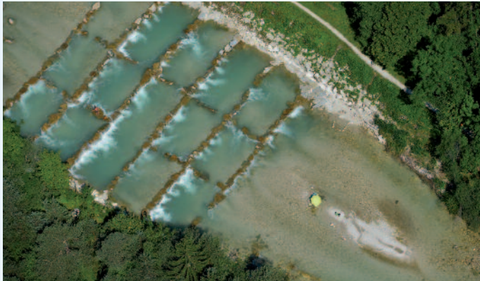
Naturnah umgebaute Pendelrampe bei km 4.4
