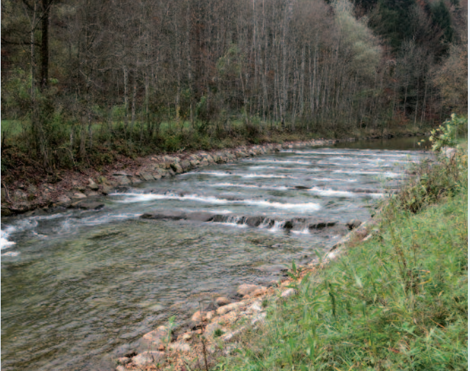
Naturnah umgebaute Pendelrampe bei km 10.1
