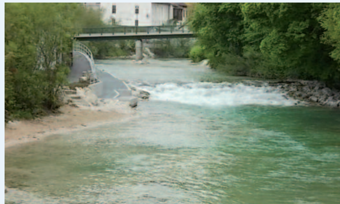
Technische Fischaufstiegshilfe beim Wagnerpolster km 0.705
