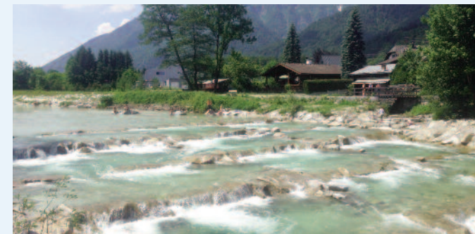
Naturnah umgebaute Pendelrampe bei km 1.8
