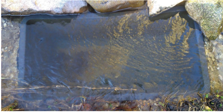
Abbildung 279: Feststoffe in der Geschiebefalle 3 am 16.01.2015
