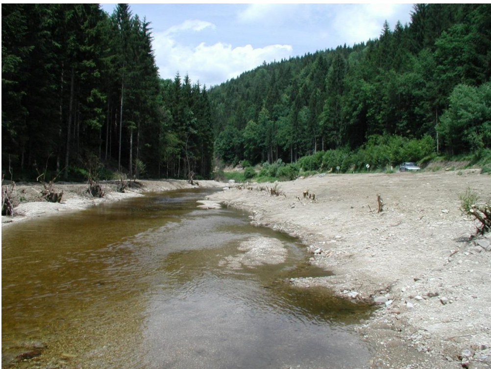
Abbildung 459: Nach dem Hochwasser 2002 wurden die entstandenen Verwerfungen an der Aist zur Gänze wieder in einen Regulierungszustand rückgeführt (Foto: Peter Anderwald).
