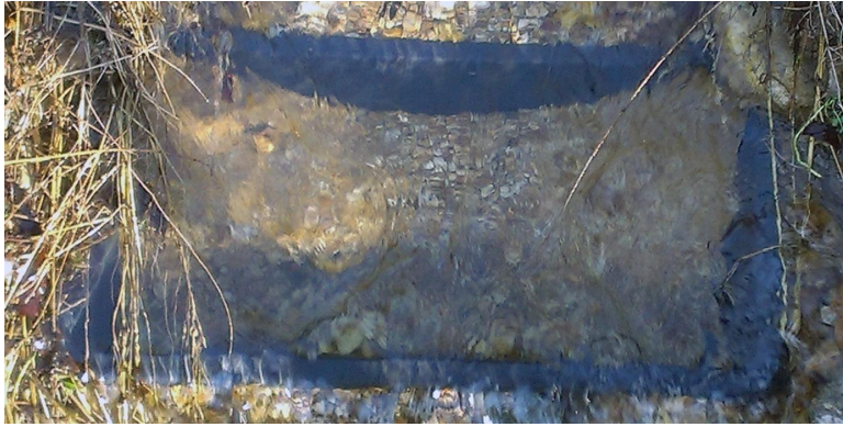
Abbildung 281: Feststoffe in der Geschiebefalle 5 am 16.01.2015
