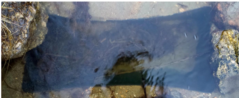
Abbildung 282: Feststoffe in der Geschiebefalle 6 am 16.01.2015
