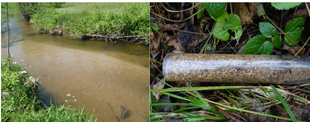
Abbildung 286: Auswirkungen von Versandung auf die Gewässersohle.
