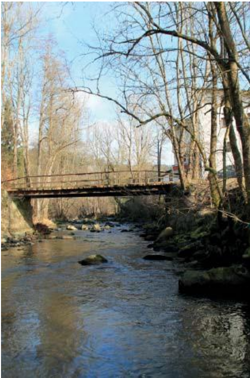
Abbildung 73: R14 - Blickrichtung flussaufwärts
