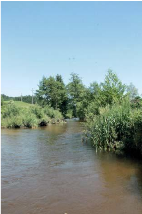
Abbildung 914: N10 - Blickrichtung flussaufwärts
