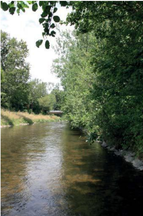
Abbildung 878: N3 - Blickrichtung flussaufwärts
