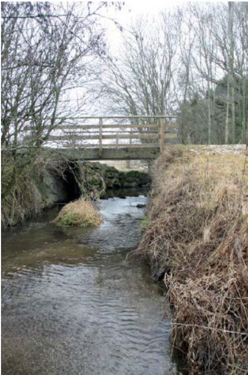
Abbildung 134: R24 - Blickrichtung flussaufwärts
