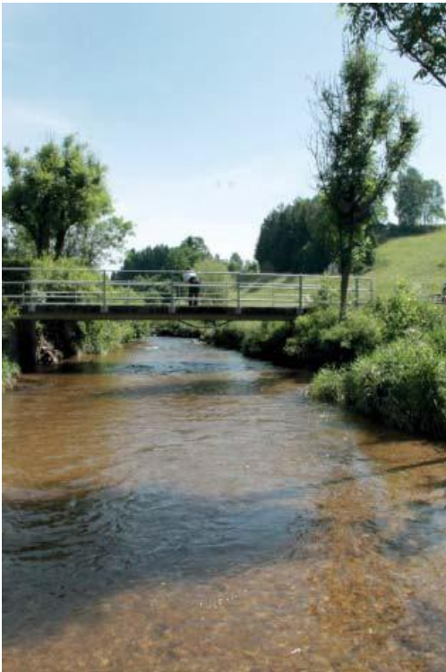
Abbildung 944: N15 - Blickrichtung flussaufwärts
