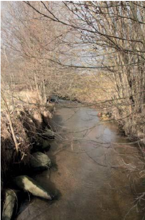
Abbildung 329: KM2 - Blickrichtung flussaufwärts
