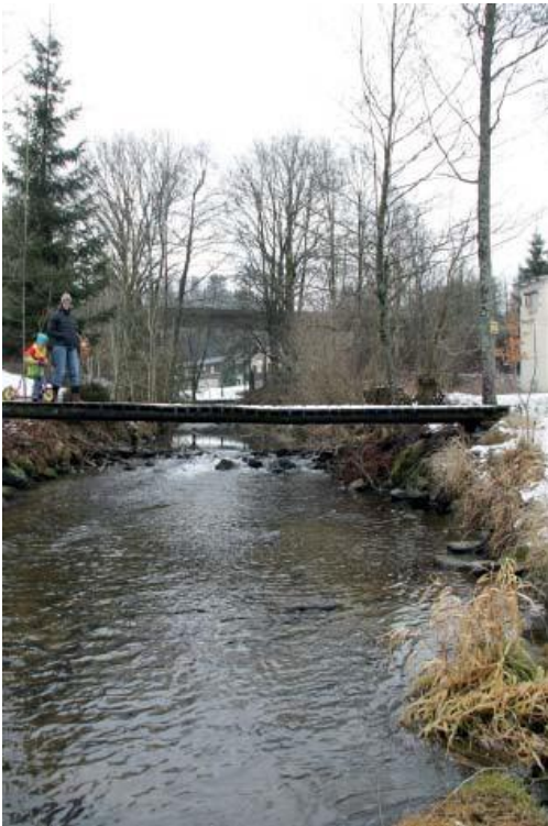
Abbildung 115: R21 - Blickrichtung flussaufwärts
