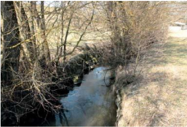
Abbildung 360: KM9 - Blickrichtung flussaufwärts
