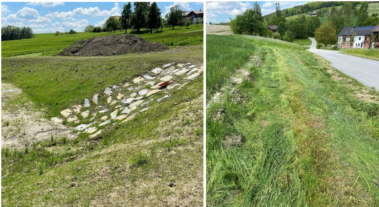
Abb. 3-51: Rückhaltebecken (links) und beispielhafter Straßenrandstreifen (rechts) beim Oberndorferbach.
