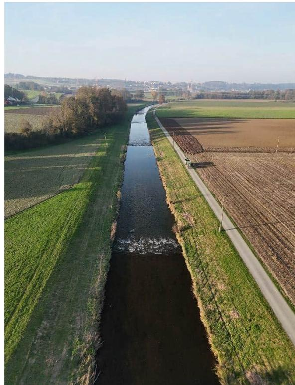
Abbildung 6: Beispiel Eintiefungstendenz gehalten - Links=regulierter Pramabschnitt (Fkm 7,0) bei Allerdings mit einer Abfolge von Querbauwerken. Rechts=regulierter Krems-Abschnitt (Fkm 23,0) mit einer Abfolge von Querbauwerken.
