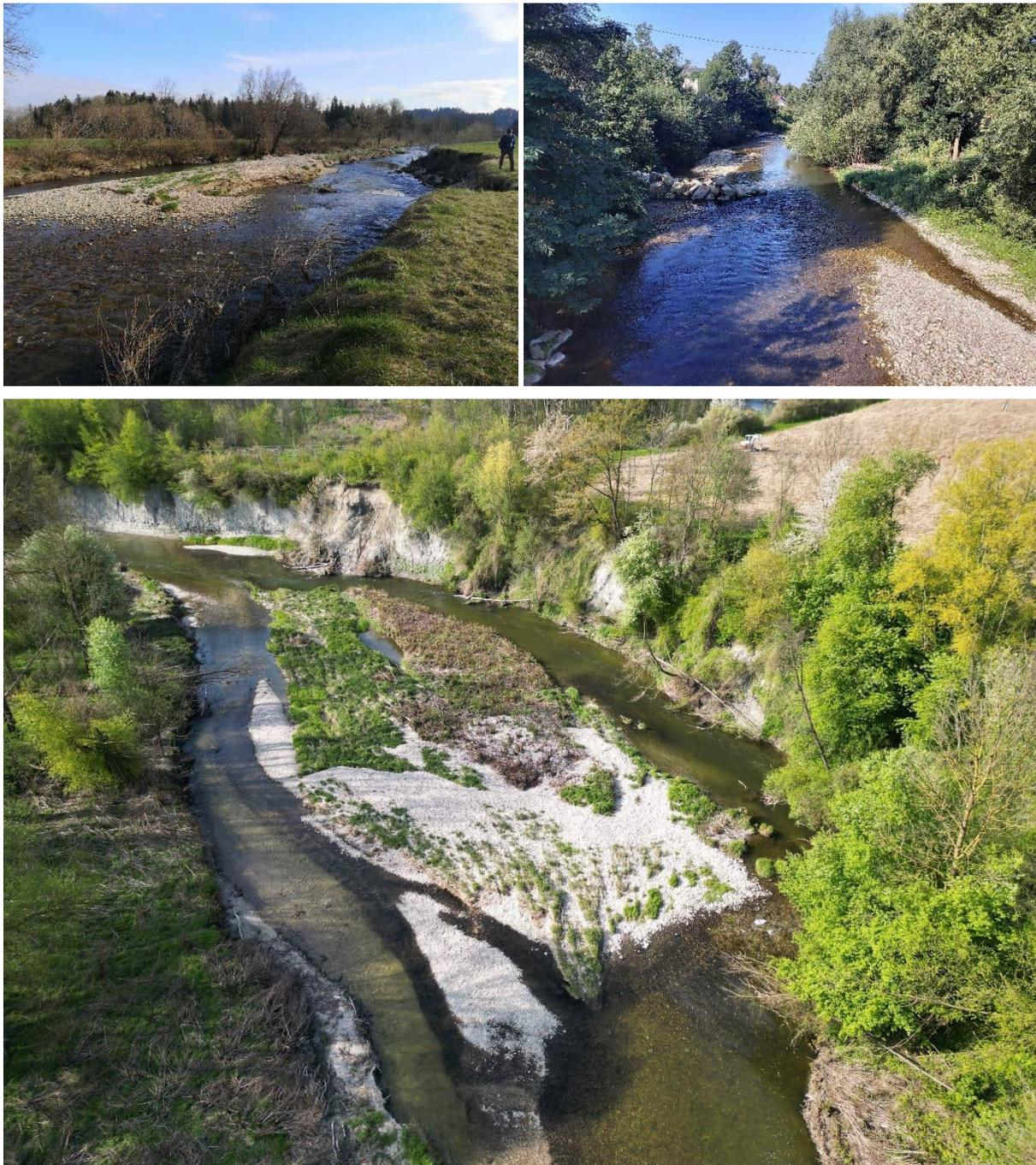
Abbildung 10: Beispiel flusstypische Kieskornverteilungen: Links oben= Aufweitungsbereich Vöckla bei Fkm 12,4. Rechts oben= Strukturierung durch Buhnenbauwerke in der Ache bei Fkm 6,3. Unten= Antiesen natürliche Mäanderstrecke.
