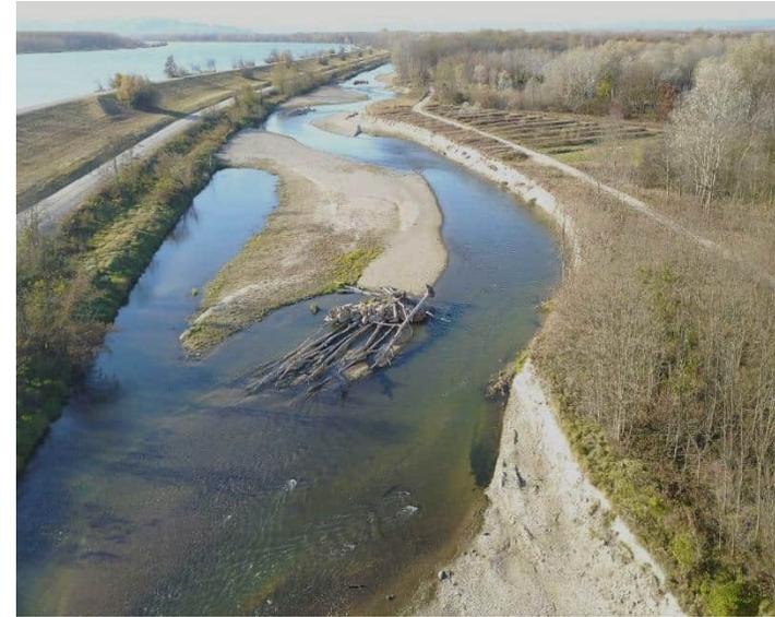
Aufweitung, Laufverschwenkung und Einbau von großvolumigen Strömungsteilern zur Schaffung fließgewässertypischer Sohlsustratverhältnisse (Bild oben rechts & unten). Durch die Maßnahmen wurde die sohlstabilisierende Wirkung der Sohlschwelle vollständig ersetzt.
