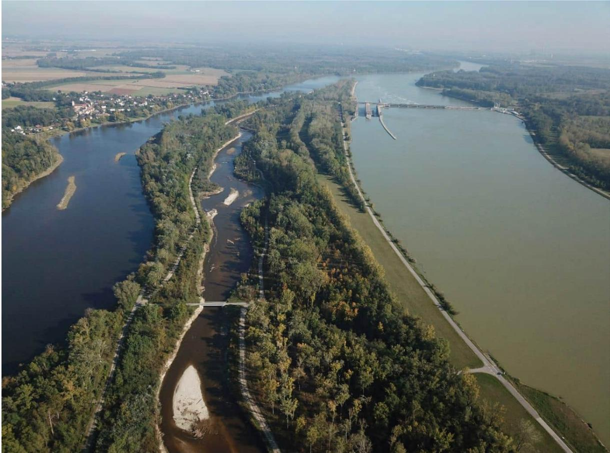
Abbildung 37: Beispiel Umgehungsarm Donaukraftwerk Altenwörth als Maßnahme für einen geschiebedynamischen Umgehungsarm bei einer großen Kraftwerksanlage (Blickrichtung flussab).
