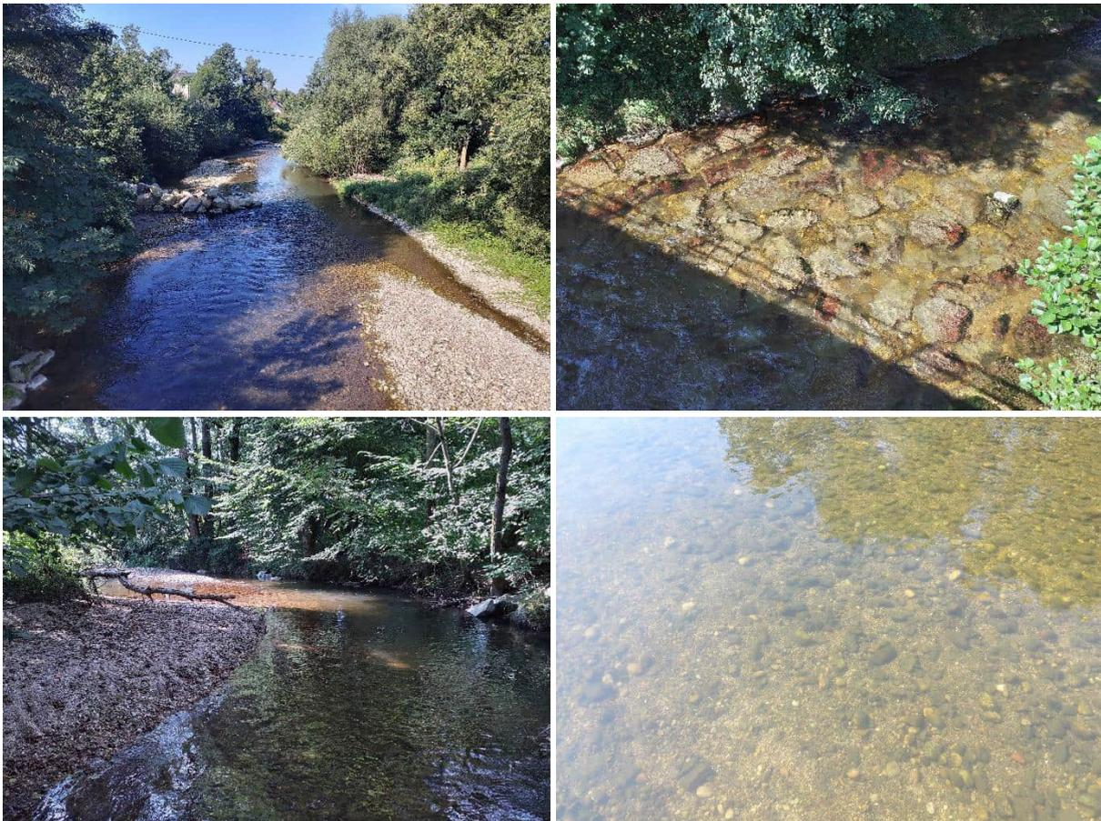
Abbildung 56: Oben links= flusstypische Kieskornverteilung durch Bühnenbauwerke (Fkm 6,3). Oben rechts= Sohlpflasterung durch Wasserbausteine (Fkm 13,5). Unten links= Mäanderabschnitt (Fkm 23,4). Unten rechts= monotone Kieskornverteilung in einer Restwasserstrecke (Fkm 8,9).
