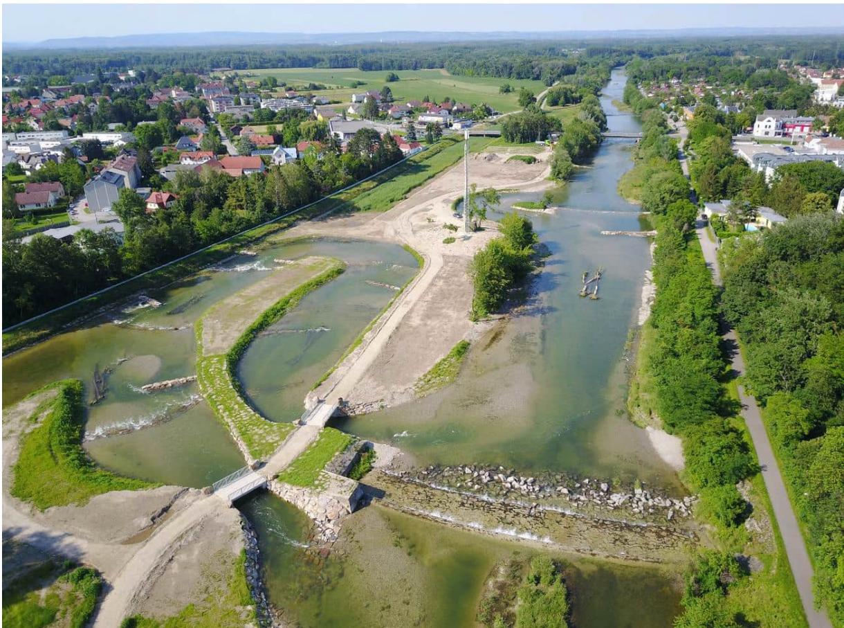
Abbildung 49: Beispiel für ein geschiebedynamisches Umgehungsgewässer an der Traisen in Traismauer.
