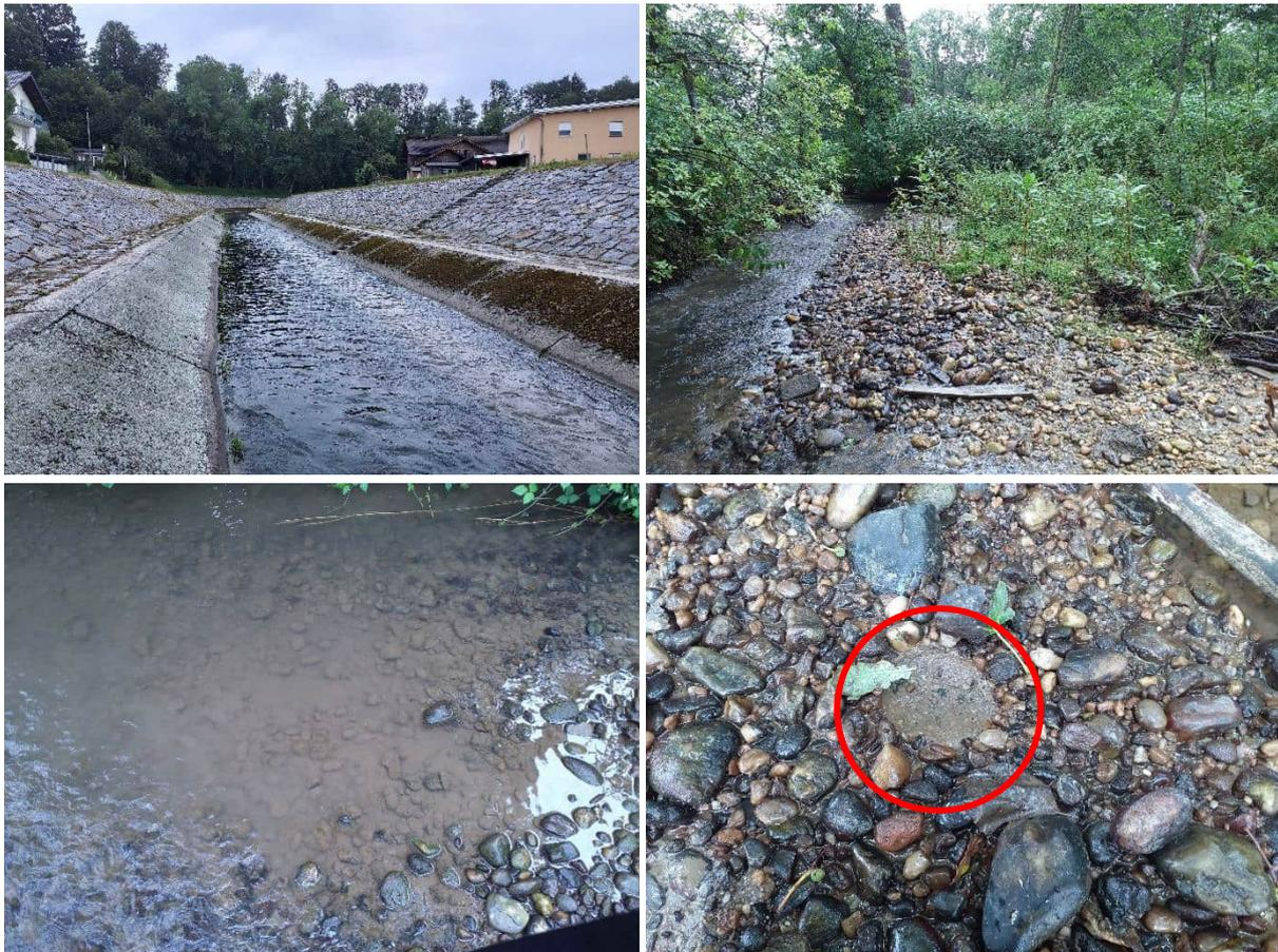
Abbildung 100: Oben links= Technisch geformtes Gerinne bei Fkm 1,0. Oben rechts= flusstypische Kieskornverteilung in der Mäanderstrecke bei Fkm 16,9. Unten links= Äußere Kolmation der Sohlfläche bei Fkm 4,5. Unten rechts= Vollständige Kolmation der Unterschicht bei Fkm 7,4.
