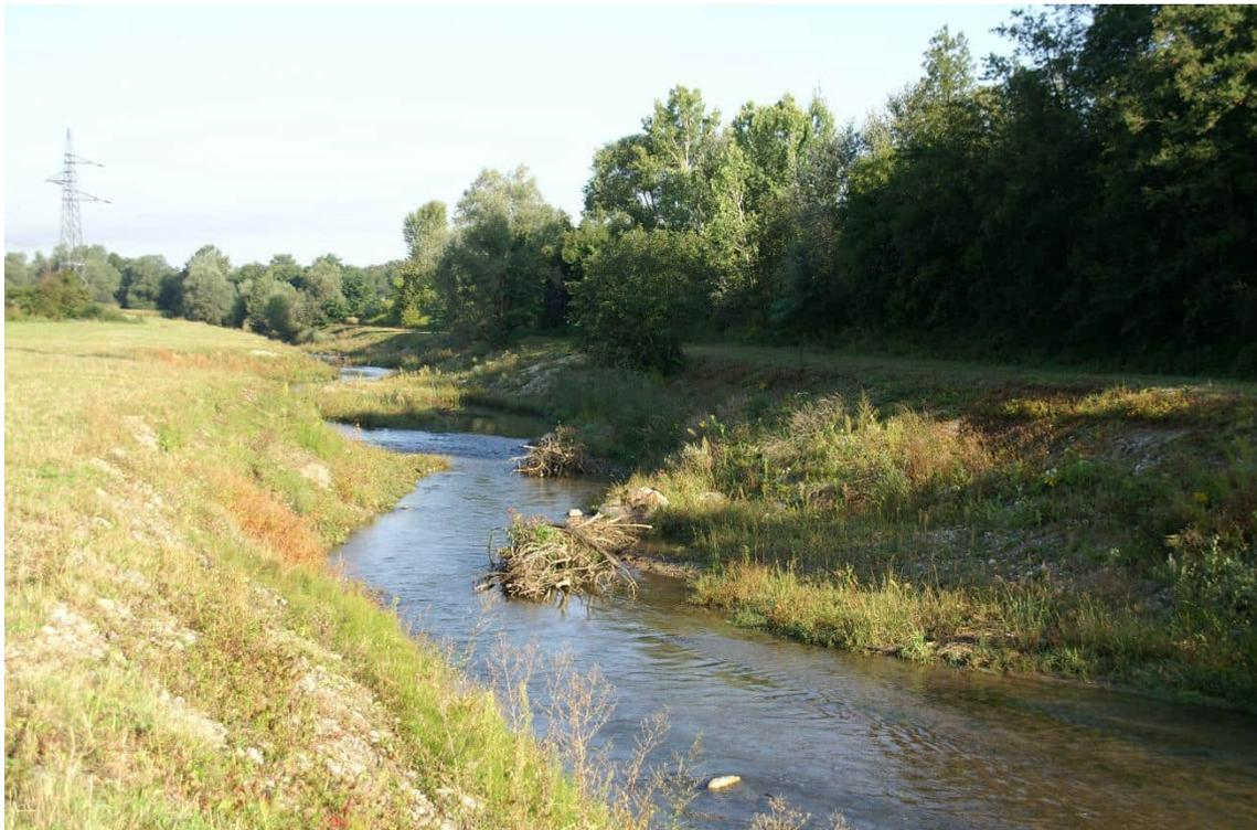
Abbildung 35: Beispiel für ein geschiebedynamisches Umgehungsgewässer – der naturnahe gestaltete Unterlauf des Gamlitzbachs als Teil der Fischwanderhilfe am Murkraftwerk Spielfeld.
