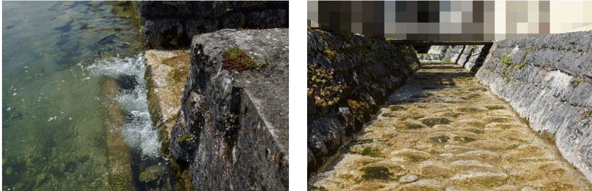
Abbildung 15: Siegesbach; links: F-km 0,0; rechts: F-km 0,001.
