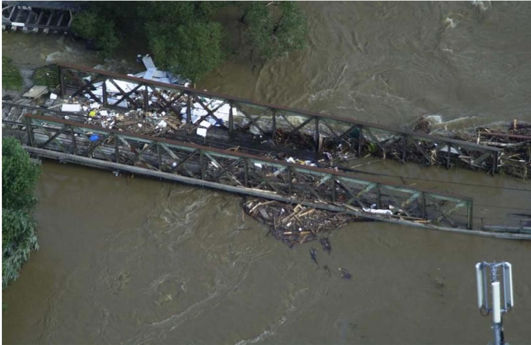
Abbildung 11: zerstörte Eisenbahnbrücke Lokalbahn in Schwertberg
