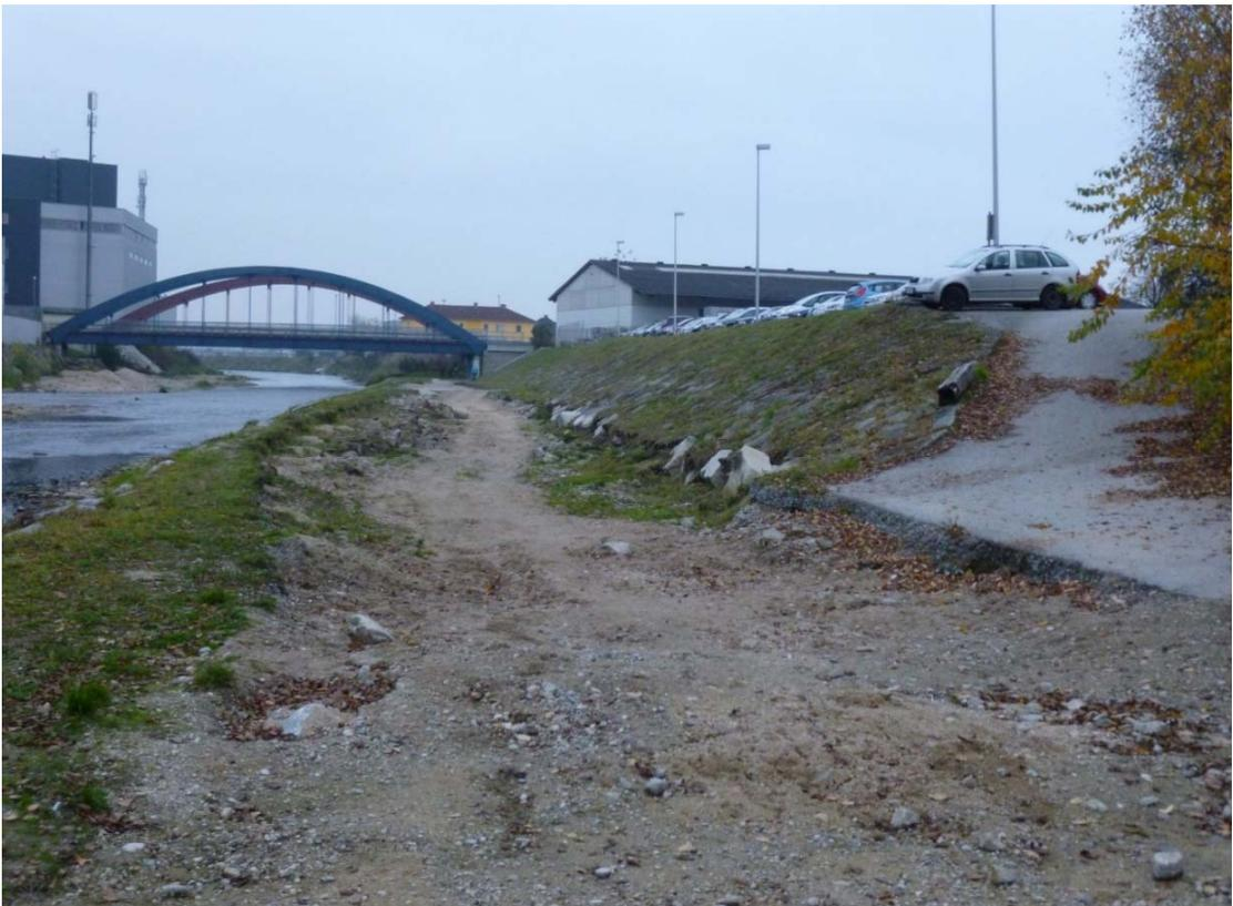
Abbildung 29: Schäden an einer Berme in Schwertberg, Blickrichtung flussabwärts
