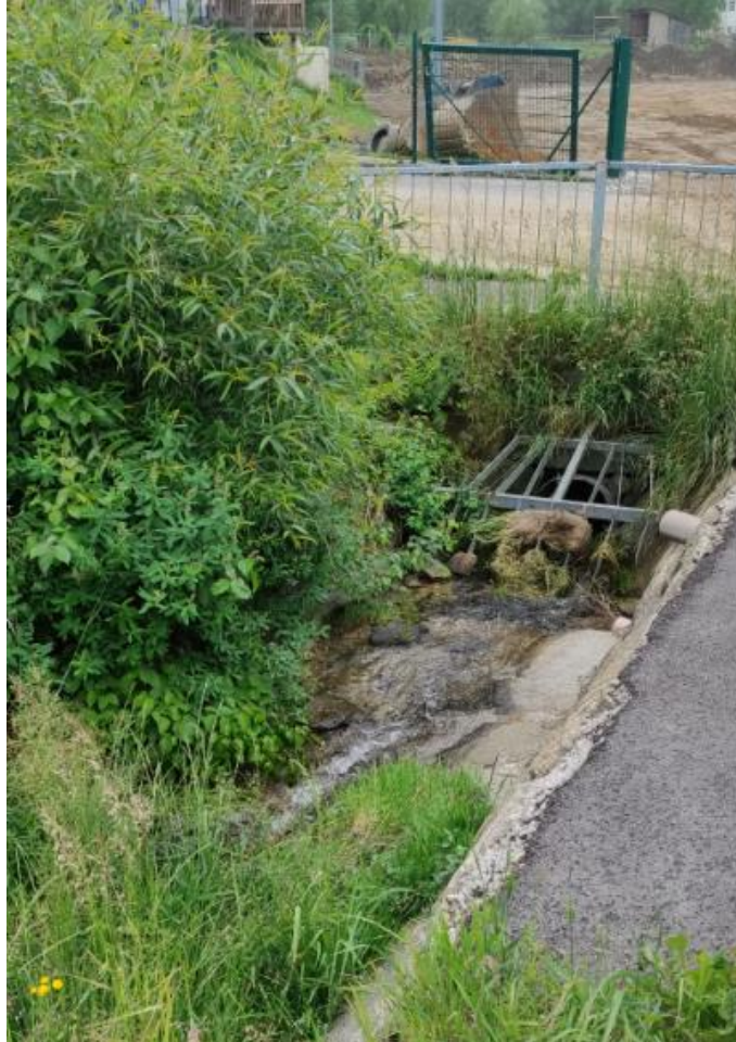
Abbildung 15: Östlich von Fußballspielplatz ist der Zubringer 2 unterirdisch in einem 80 m langen Durchlass geführt
