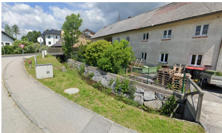
Abbildung 7: Die regulierte Strecke des Kettenbaches flussabwärts von der Mündung des Zubringers 1 in den Kettenbach (Google - Street View)
