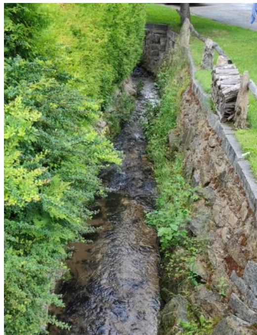
Abbildung 17: Kettenbach flussabwärts von der Brücke an der Landesstraße L1499 (Tischberger Straße)
