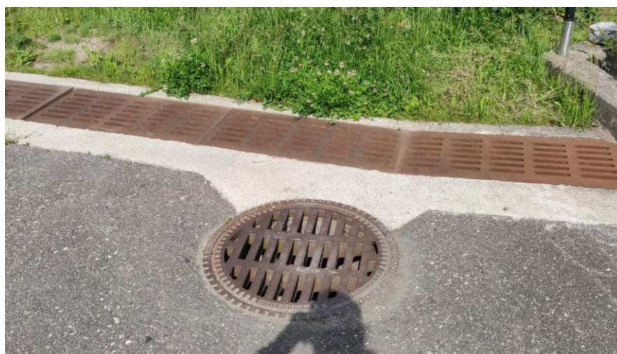
Abbildung 22: Die Straßenrinne mit dem Durchlass
