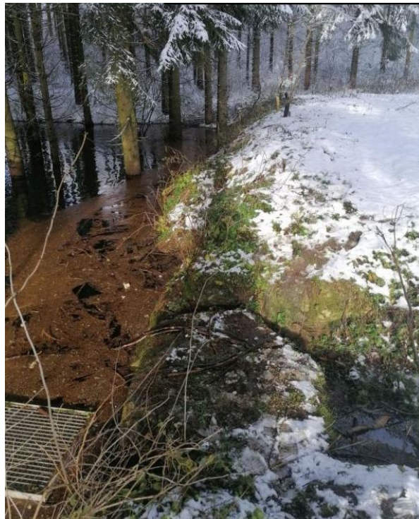
Abbildung 24: Ein kleines Retentionsbecken mit Einlauf (Foto: Vermessung Hainzl & Partner)
