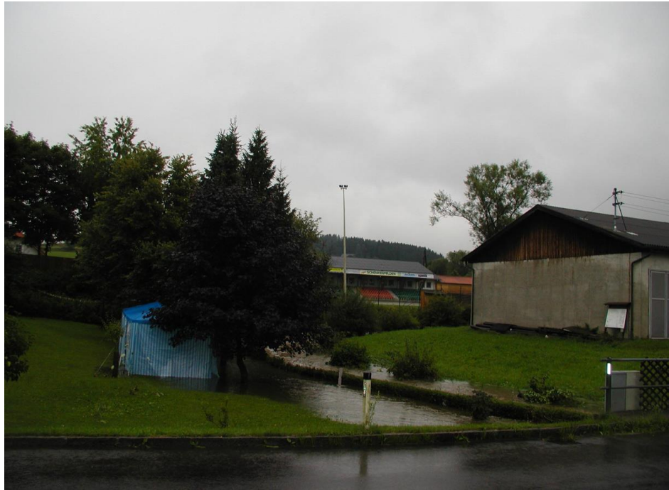
Abbildung 42: Kettenbach flussaufwärts der Brücke der Landesstraße L1499 (Tischberger Straße)
