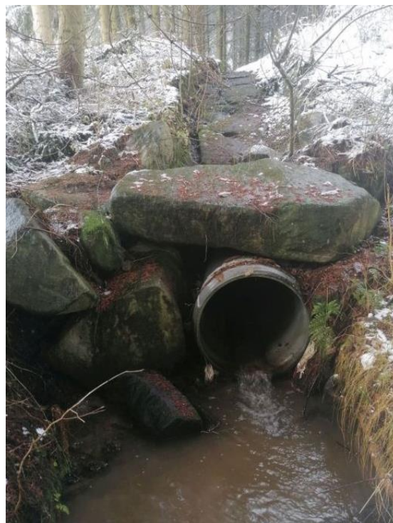
Abbildung 25: Ein kleines Retentionsbecken mit Auslauf (Foto: Vermessung Hainzl & Partner)
