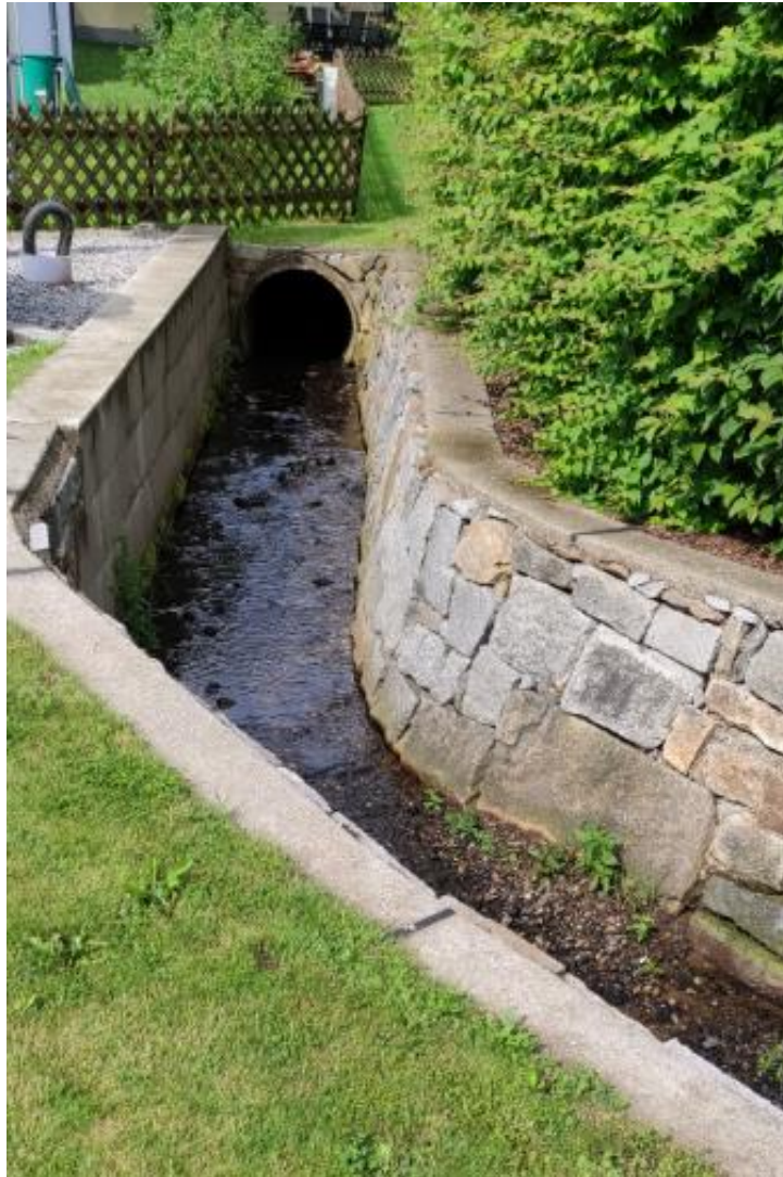
Abbildung 5: Die regulierte Strecke des Zubringers 1
