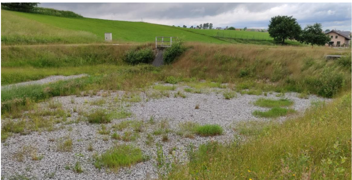
Abbildung 4: Regenrückhalteteich nördlich von Fa Wöss Ladenbau – Metalltechnik GmbH
