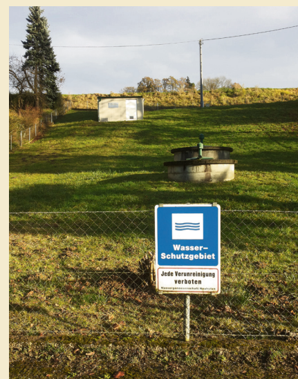
Bild 1: Der Schutz von Wasserversorgungsanlagen hat oberste Priorität.
