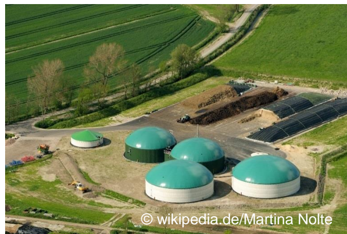
Abbildung 66: Luftbild einer Biogasanlage
