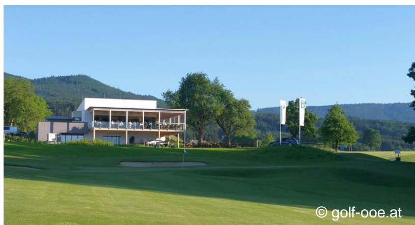
Abbildung 69: Klubhaus eines Golfplatzes in Regau/OÖ
