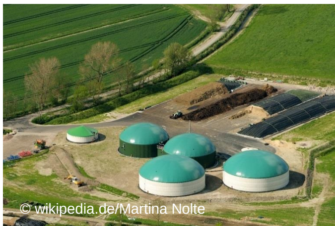
Abbildung 75 Luftbild einer Biogasanlage
