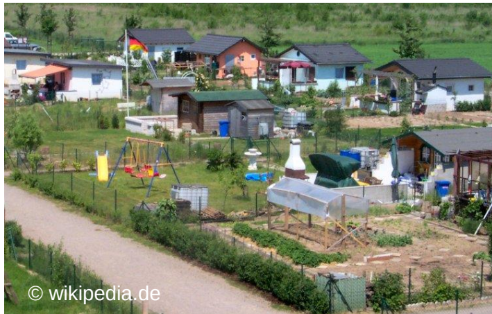
Abbildung 76 Beispiele für Gebäude in Dauerkleingärten
