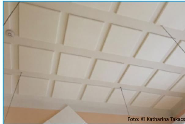
selbst mit speziellen Möbeln oder ähnlichem. Man benötigt allerdings immer relativ viele Quadratmeter schallabsorbierendes Material. Typischerweise ist der Flächeninhalt aller verbauten schallschluckenden Materialien, die an Decke und Wänden verteilt werden, etwa so
