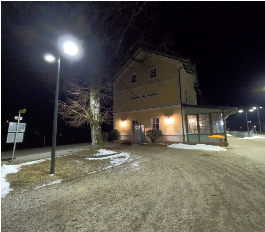
Abbildung 17 - Beleuchtungssituation bei der Bahnhofstation Grünau im Almtal.
