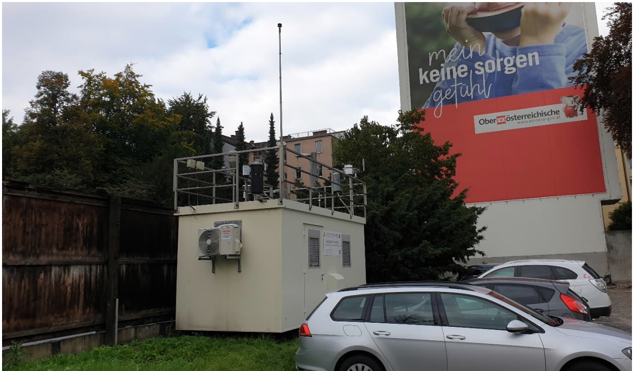
Station S431 Linz-Römerberg, Ansicht Richtung Nordwest, Aufnahme datum: 13. Oktober 2021
