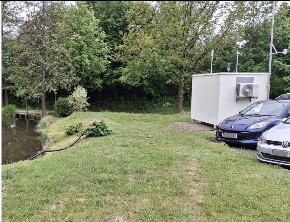
Aufnahmedatum: 19.05.2026 in Richtung West bis Nordwest
