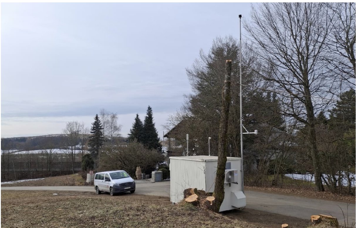
Abbildung 6: Messstelle S283 in südwestliche Richtung (Aufnahmedatum: 12.2.2025)
