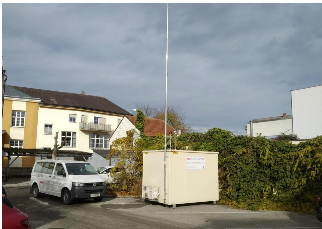
Abbildung 4: Messstelle S190 in nördliche Richtung (Aufnahmedatum: 18.11.2019)
