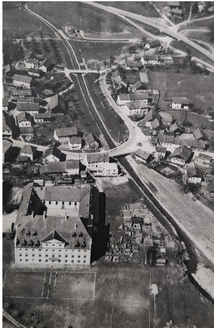
Abb. 2: Die hart regulierte Pram im Ortsgebiet von Zell. Im Bereich des Schlosses sind unten rechts das ursprüngliche Gerinne und die Bauarbeiten am neuen zu erkennen (aus SAGEDER 2015a).
