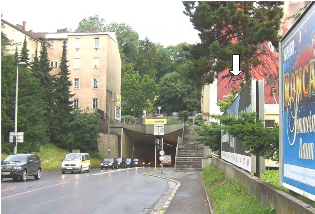
Abbildung 48: Foto Station Römerberg Richtung Norden
