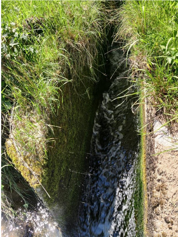
Abbildung 70: Ausleitungskanal Kläranlage bei Flkm 15,2.
