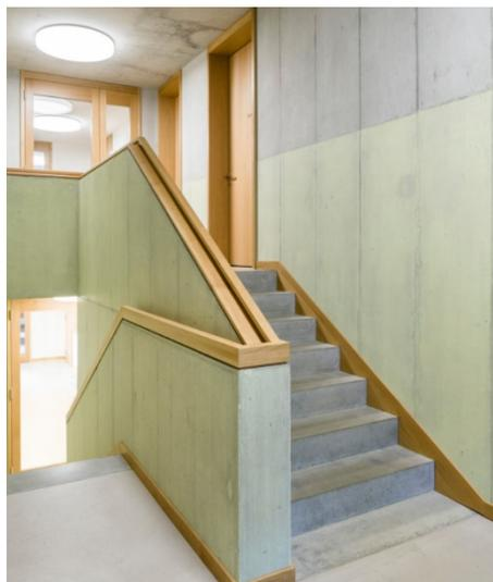
Abbildung 11: Sichtbetonwände aus Recyclingbeton
