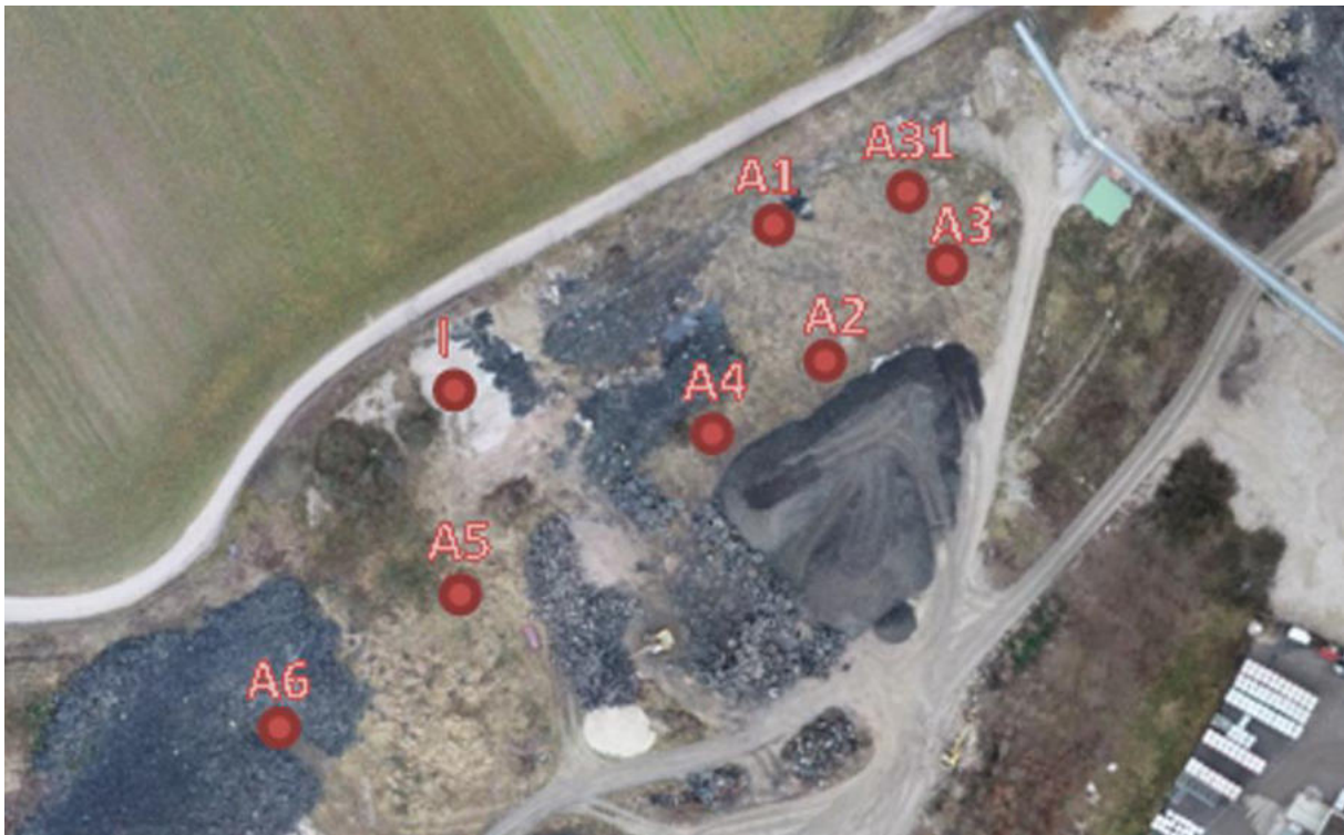
Abbildung 7: Positionen der aktuellen Messsonden auf dem „Alten Reifenlager“
