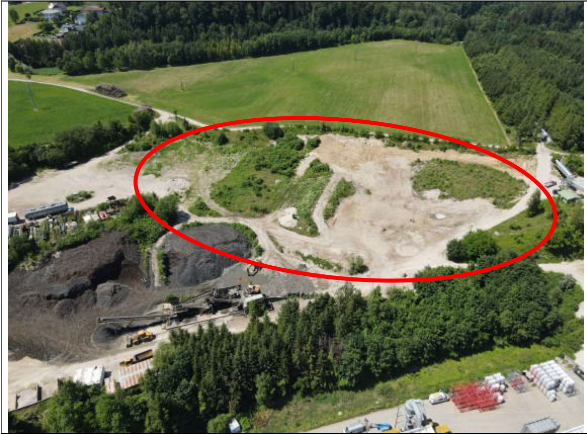
Abb. 10: Drohnenaufnahme des Projektbereichs „Altes Reifenlager“ (Quelle Asamer Kies- und Betonwerke GmbH, 30.06.2022)
