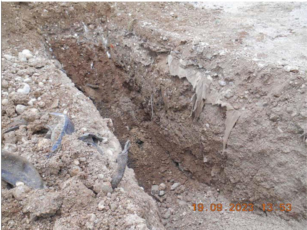
Abb. 2 Schurf 1 vom Böschungsfuß unter das Wegplanum reichend, ungefähr auf Höhe von Schnitt AR7; max. Schurftiefe ca. 2 m.
