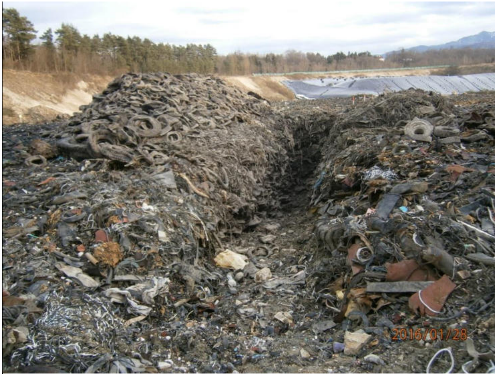
Abb. 4 Ca. 3 m tiefe Erkundungsschürfe im Sanierungsbereich „Lager Bienenhütte“. Fotos: J. Ebner, ERG GmbH, 28.01.2016
