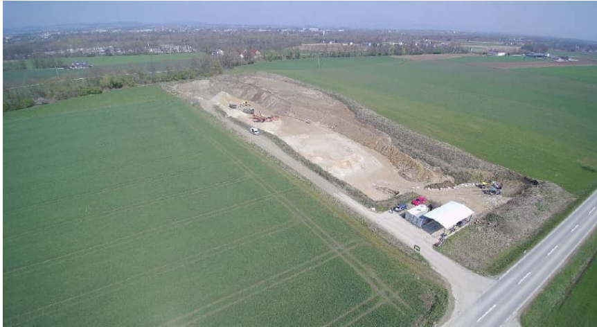
Abbildung 2: S. 47 des Gewinnungsbetriebsplanes vom 10.09.2021 entnommen; links des Weges: Teile der projektierten Neuaufschlussfläche „Weißkirchner Feld“ rechts des Weges: Bestandsabbau „Lehner“
