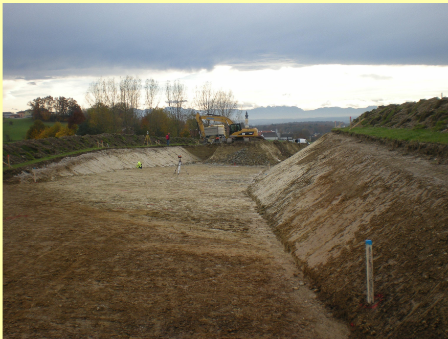
(Abb.: Erdarbeiten November 2014)
