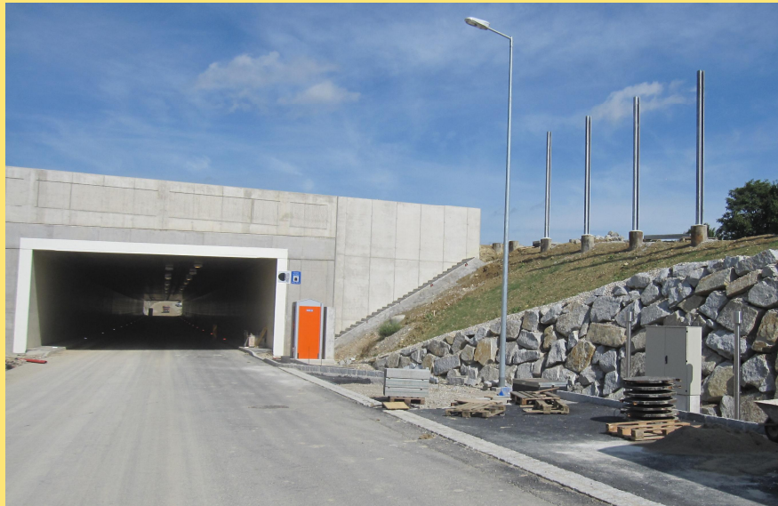
(Abb.: Grünbrücke Metz)
