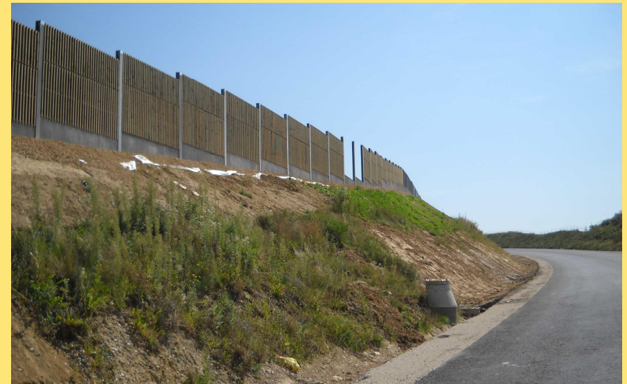
(Abb.: Lärmschutzwand am Rabenberg)
