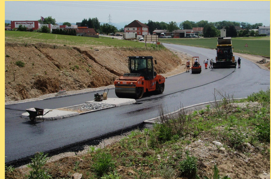
(Abb.: Asphaltierungsarbeiten Bereich Anschluss Heuberg)
