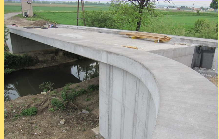
(Abb.: Krusteinerbachbrücke Zufahrt Eckmayr)
