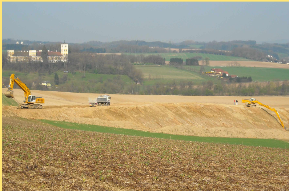
(Abb.: Dammschüttung Bereich Volkersdorf)
