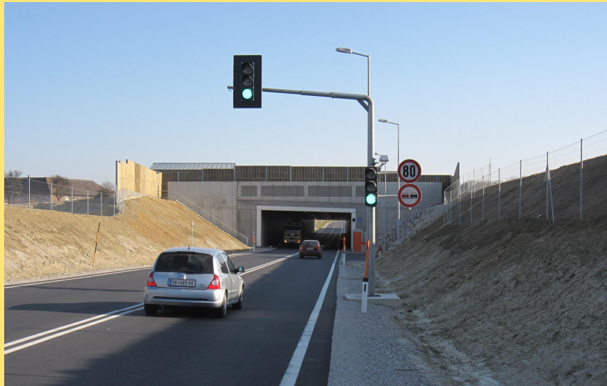
(Abb.: Grünbrücke Metz-Nord)
