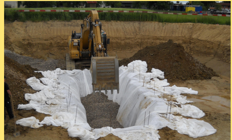
(Abb.: Errichtung des Regenrückhaltebeckens)
