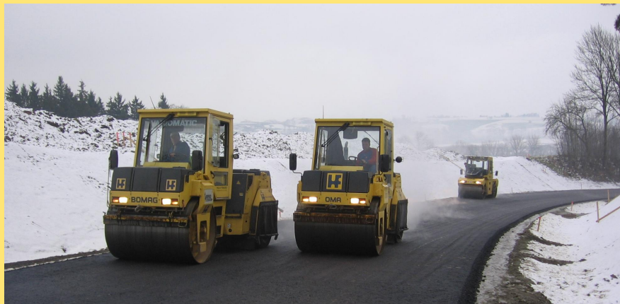
(Abb.: Asphaltierungsarbeiten 1. Bauabschnitt)
