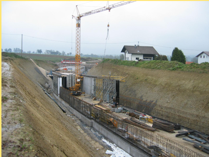
(Abb.: Errichtung Grünbrücke)
