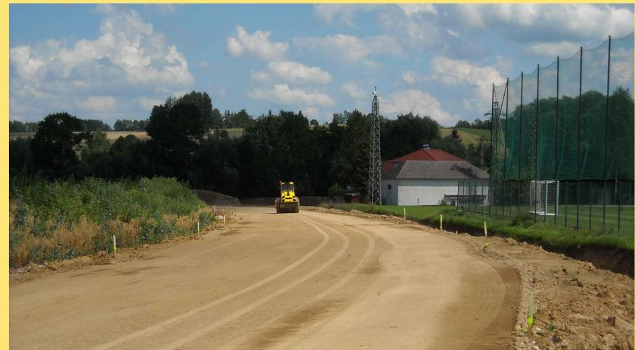
Abb.: Verdichtungsarbeiten am Unterbauplanum
