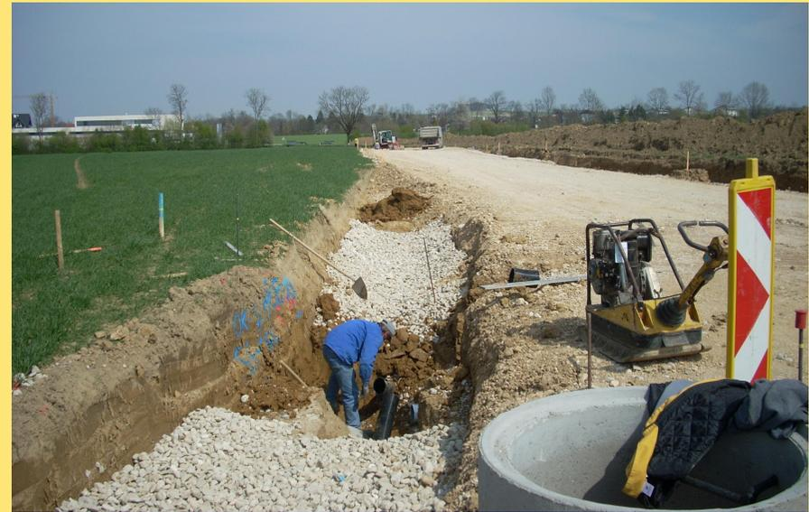
Abb.: Herstellung der Straßenentwässerung
