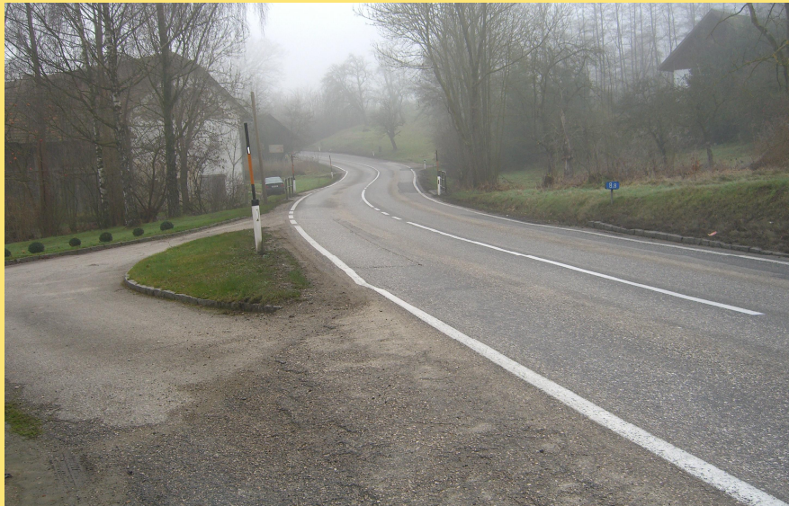
(Abb.: Bestandsaufnahme B134 im Bereich Ortsdurchfahrt Parzham)
