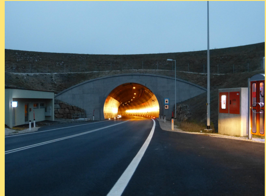
(Abb.: Ostportal Tunnel Lambach, Foto Land OÖ)
