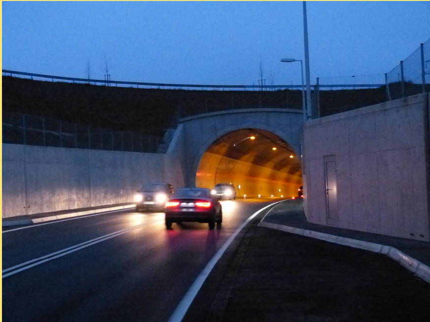
(Abb.: Westportal Tunnel Lambach, Foto Land OÖ)
